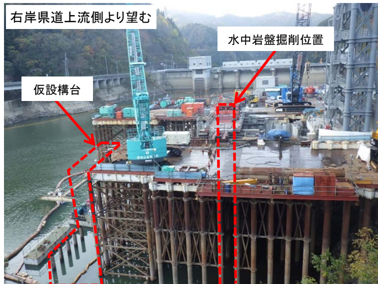
11月19日 掘削機による流入水路掘削、仮設構台解体
