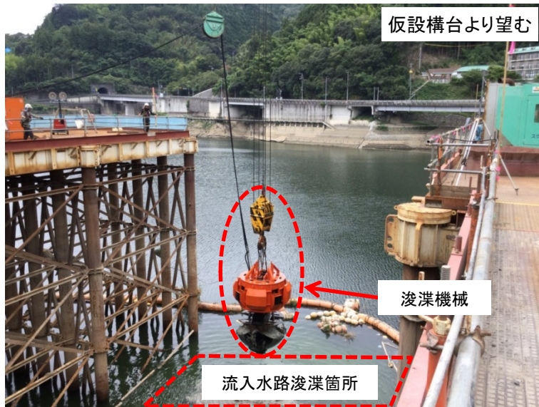
9月3日 流入水路浚渫
