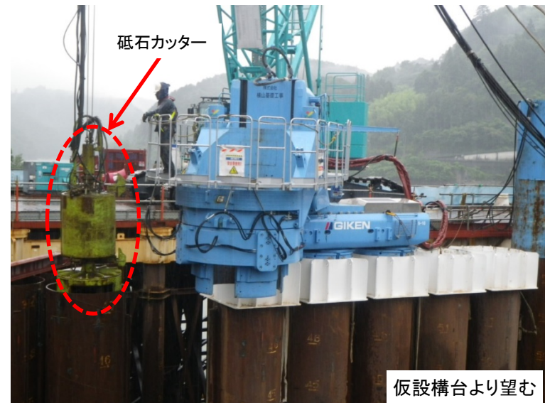
6月25日 鋼管矢板切断
