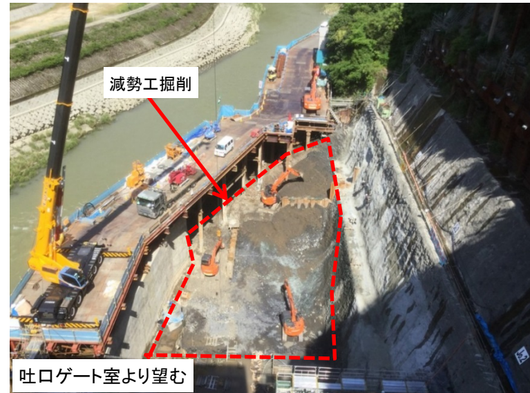
5月14日 減勢工掘削
