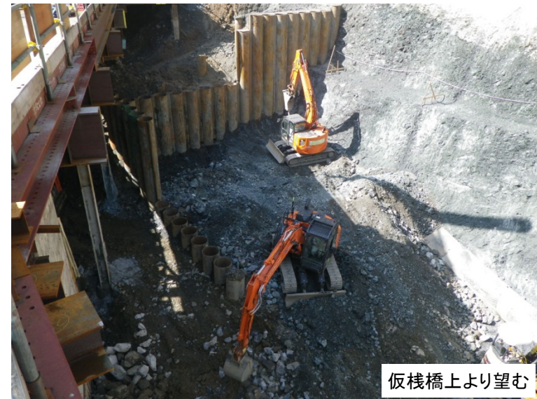
3月26日 減勢工掘削
