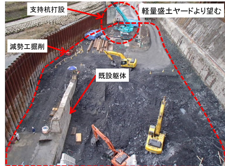
11月27日 減勢工掘削および支持杭打設作業
