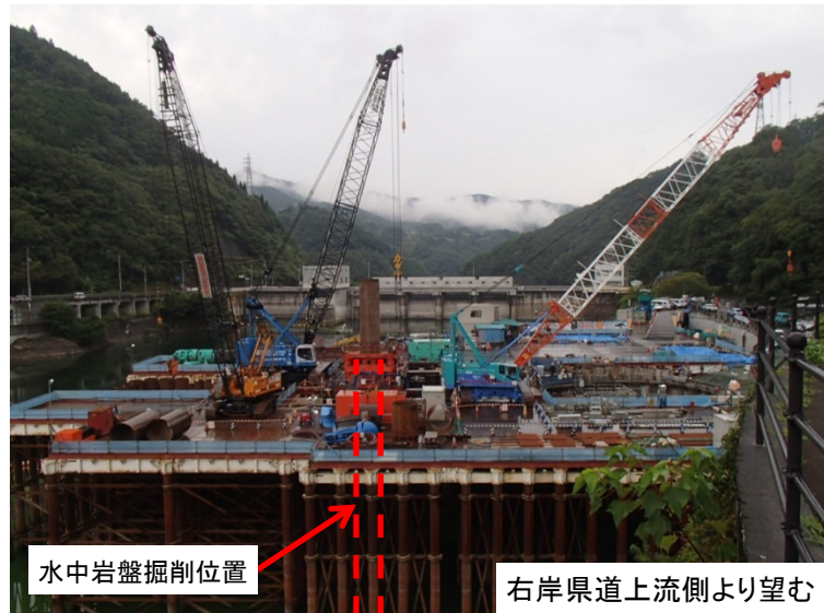
8月28日 掘削機による水中岩盤掘削作業
