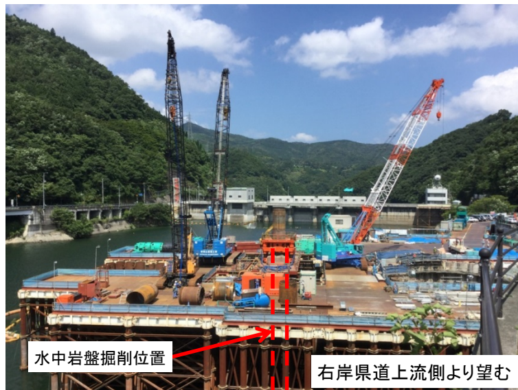
8月7日 掘削機による水中岩盤掘削作業
