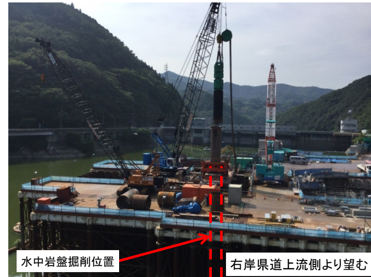
8月14日 掘削機による水中岩盤掘削作業
