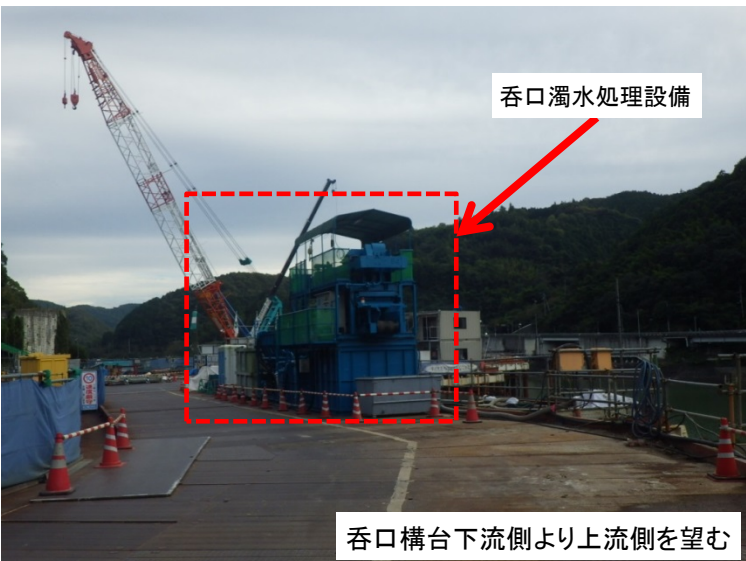
10月17日 呑口濁水処理設備設置完了
