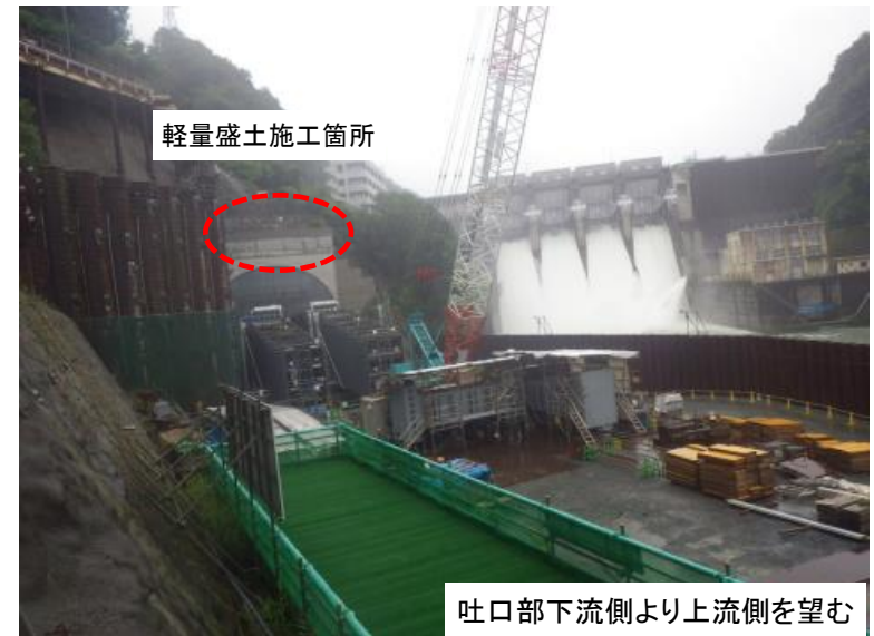
7月11日 軽量盛土工
