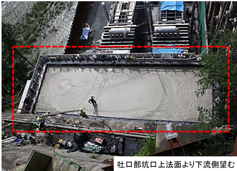
7月4日 軽量盛土工
