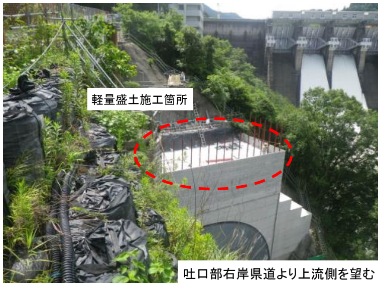
7月18日 軽量盛土工
