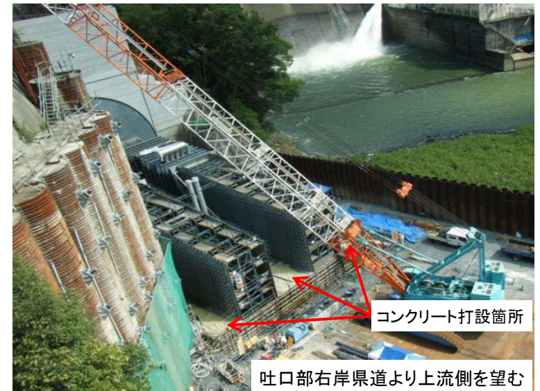
7月25日 吐口部コンクリート打設
