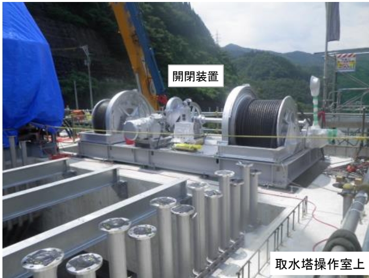
8月1日 開閉装置据付
