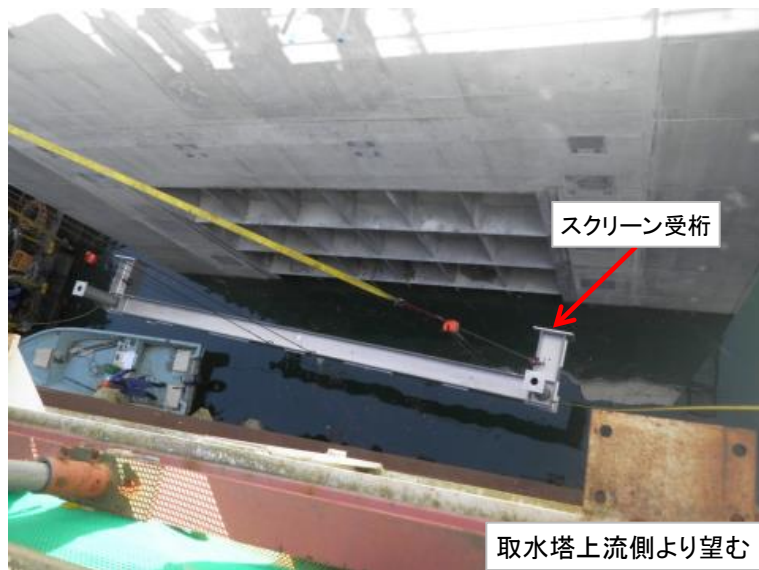
4月18日 スクリーン受桁吊込み
