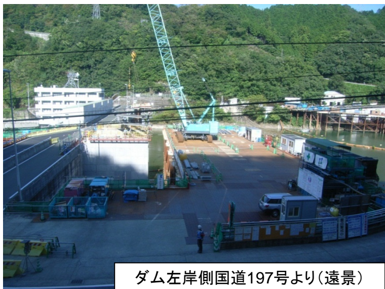
9月21日 据付架台設置作業
