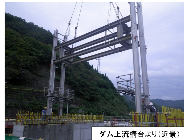
9月28日 据付架台設置作業
