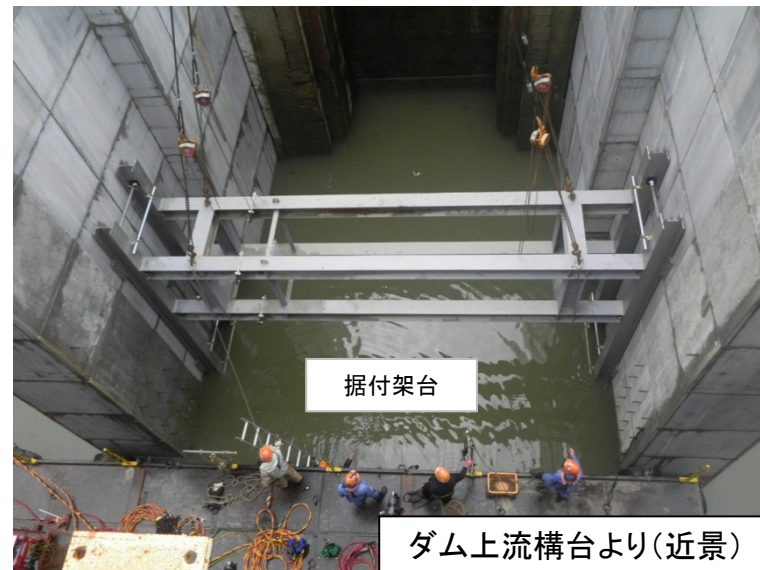
9月14日 据付架台設置作業
