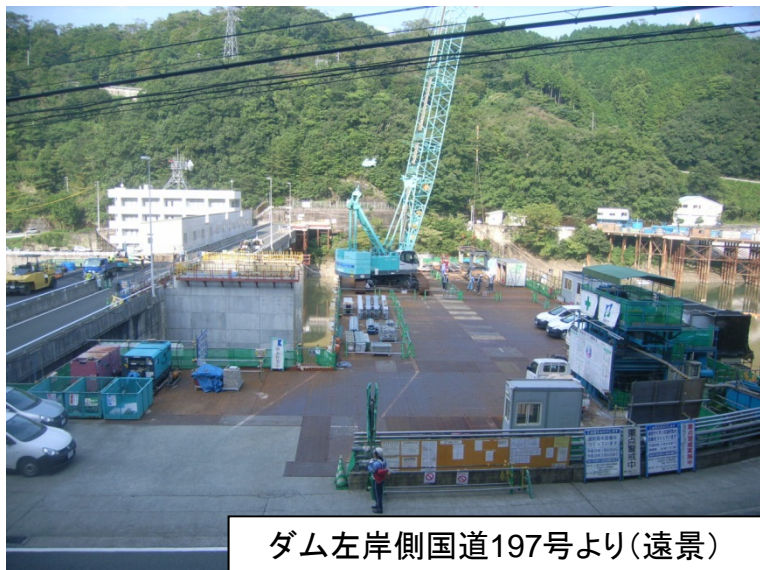
9月7日 据付架台設置作業
