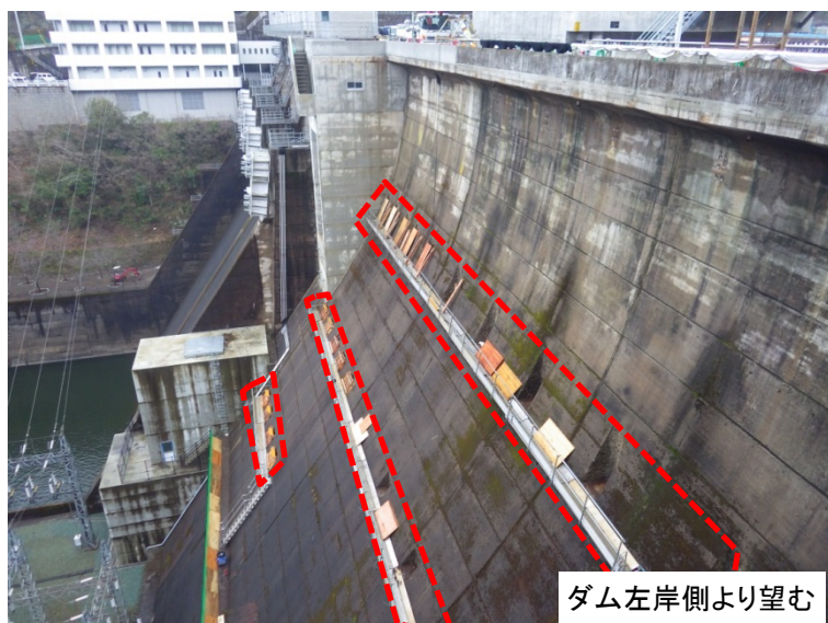
2月20日 下流側仮設構台支持杭撤去跡の補修
