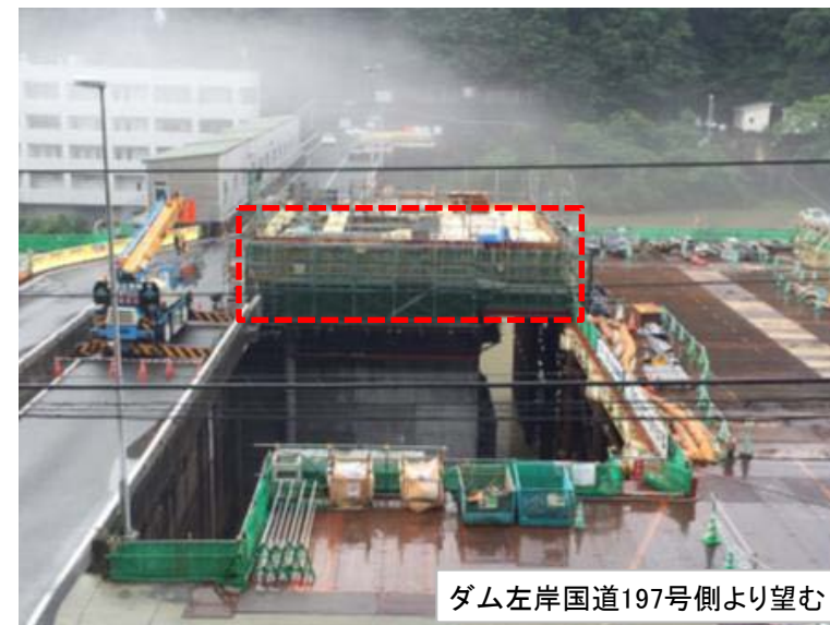
6月27日 取水塔床板コンクリート養生
