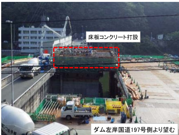
6月20日 取水塔床板コンクリート打設
