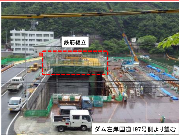
6月6日 取水塔床板鉄筋組立
