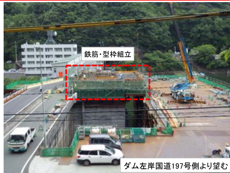
6月13日 取水塔床板鉄筋・型枠組立
