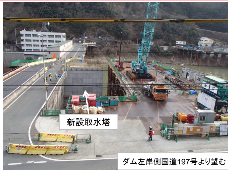
2月8日 水中部二次コンクリート打設
