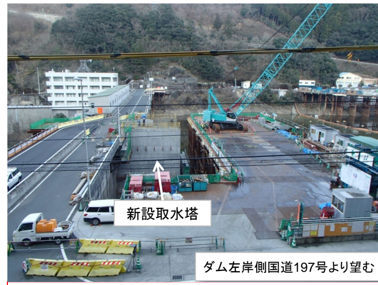
2月22日 気中部二次コンクリート打設
