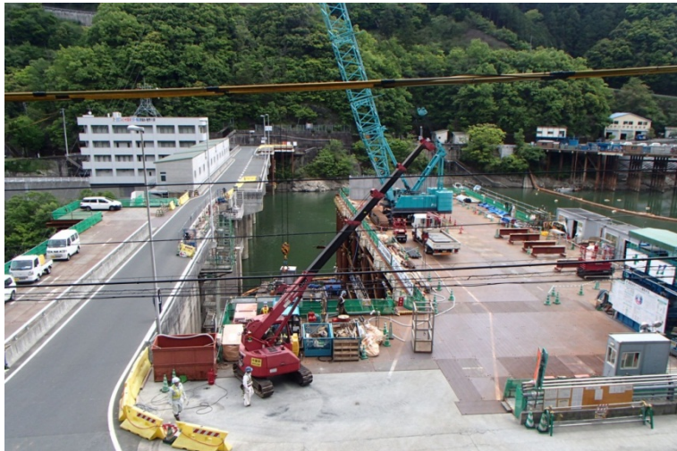
ダム左岸側国道197号より(遠景)
