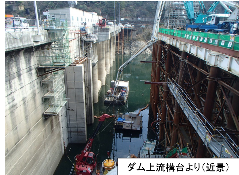
3月9日 水中コンクリート打設
