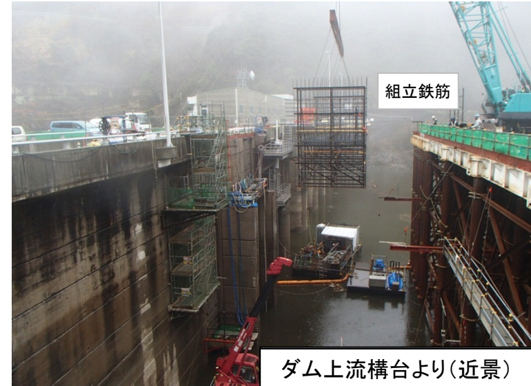
3月23日 組立鉄筋設置
