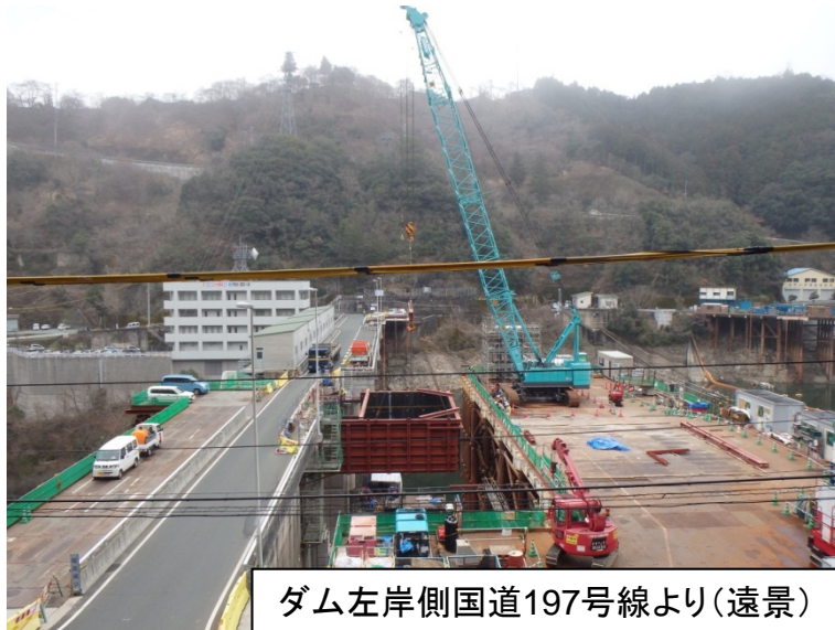
3月2日 大型型枠設置
