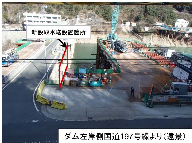
2月16日 新設取水塔基礎構築
