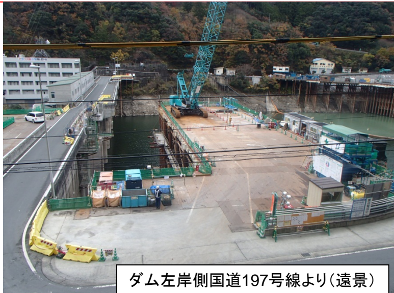
12月1日 取水塔基礎部コンクリート打設(水中部)
