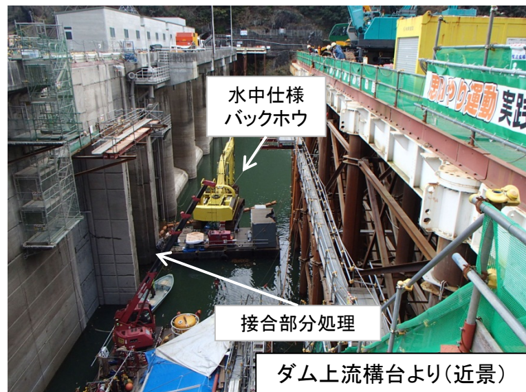
12月22日 新設取水塔接合部分処理(はつり)
