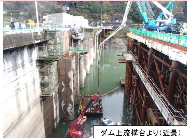
12月8日 取水塔基礎部コンクリート打設(水中部)
