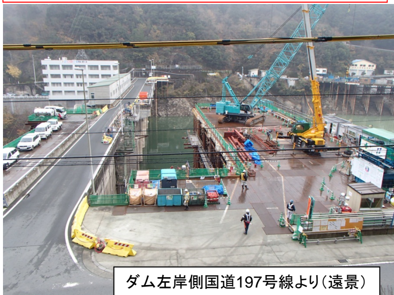
12月15日 取水塔基礎部コンクリート打設(水中部)
