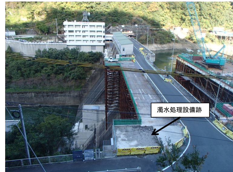
10月27日 濁水処理設備撤去
