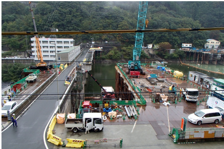
ダム左岸側国道197号線より(遠景)
