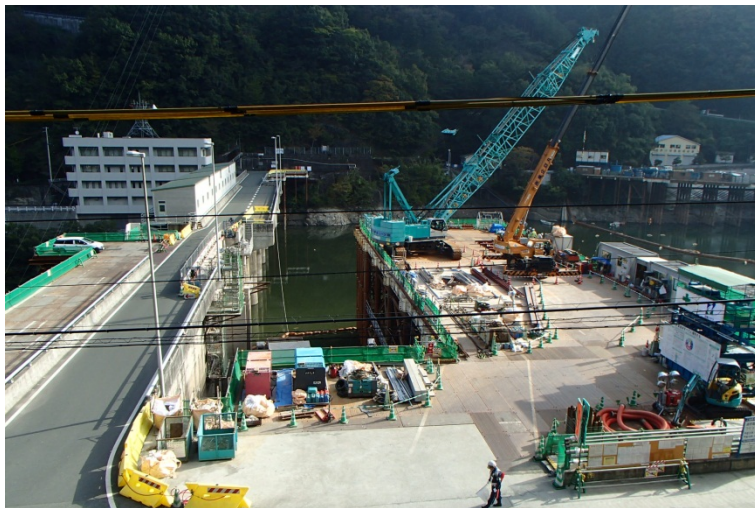
ダム左岸側国道197号線より(遠景)
