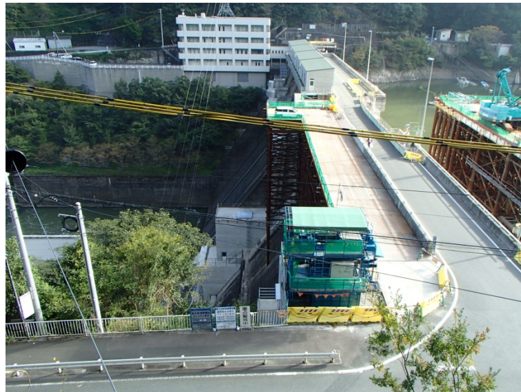
10月20日 低水放流バルブ室構築完了
