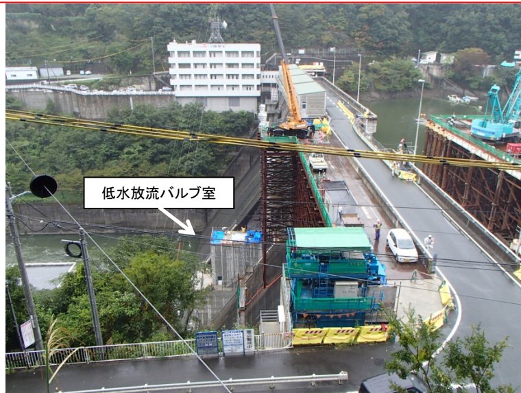
10月6日 低水放流バルブ室構築
