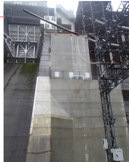
10月14日 低水放流バルブ室構築完了
