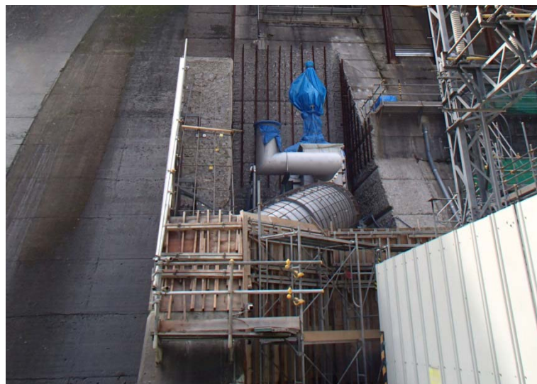
7月22日 ゲート室構築
