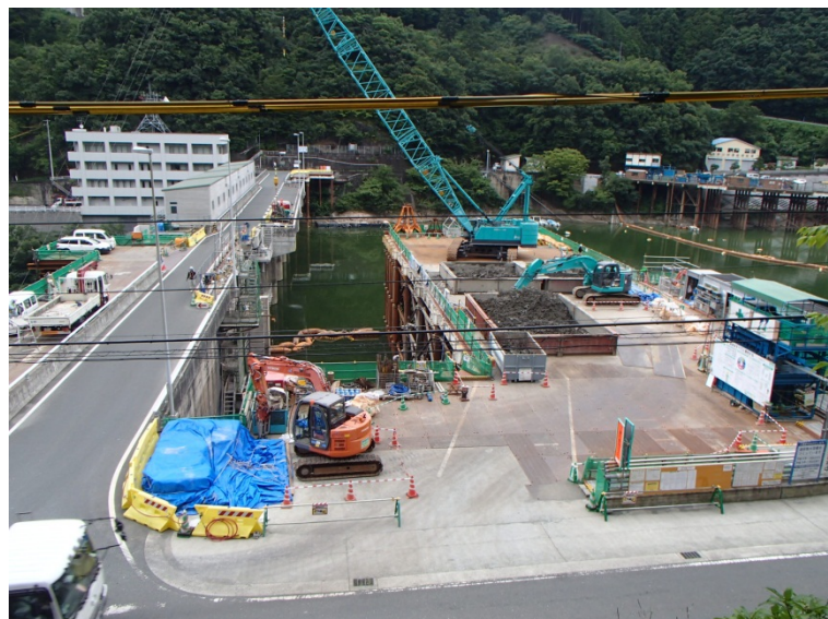
7月22日 浚渫作業
