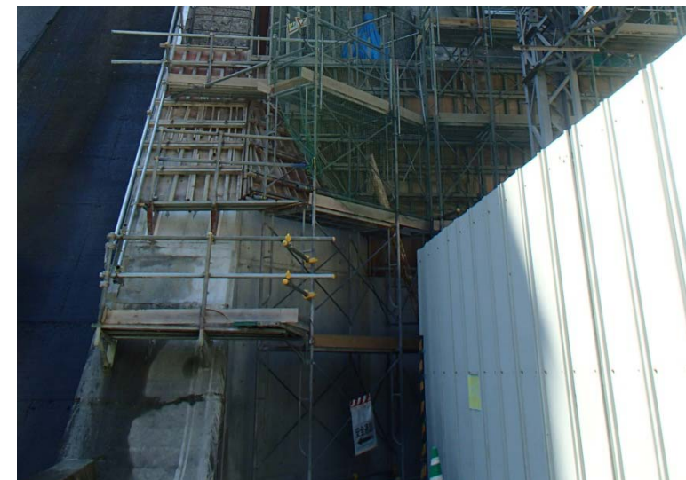
7月28日 ゲート室構築
