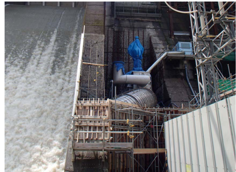
7月14日 ゲート室構築
