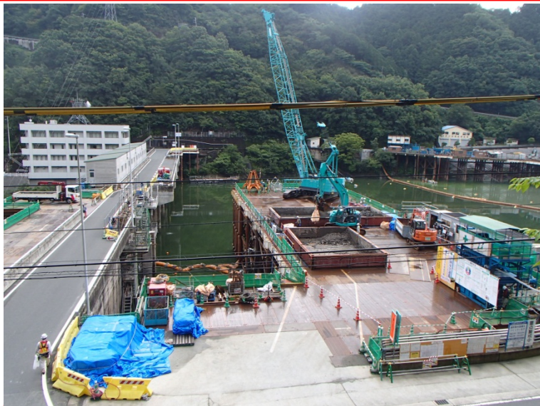
7月7日 浚渫作業
