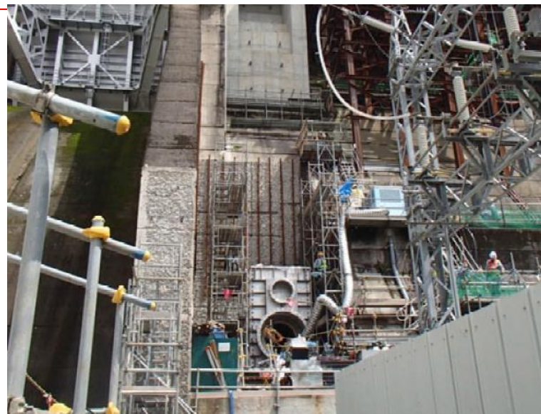
6月9日 放流ゲート設置
