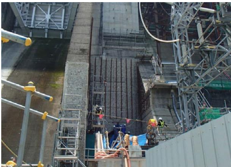
6月2日 放流管巻立てコンクリート打設
