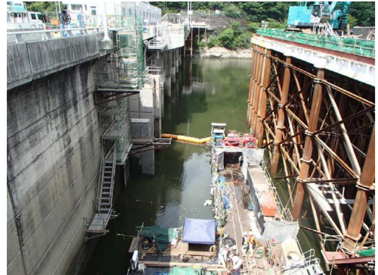
6月9日 取水塔撤去
