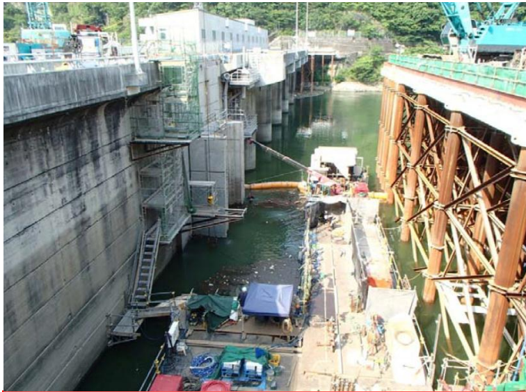
6月2日 取水塔撤去
