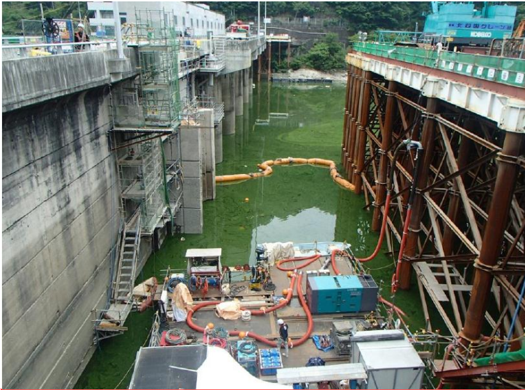
6月30日 浚渫作業
