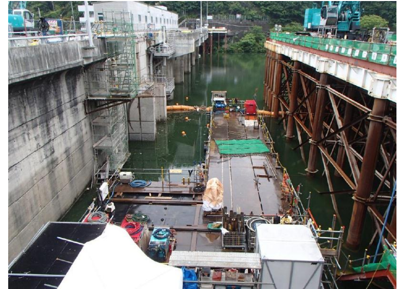
6月23日 取水塔撤去、浚渫作業準備
