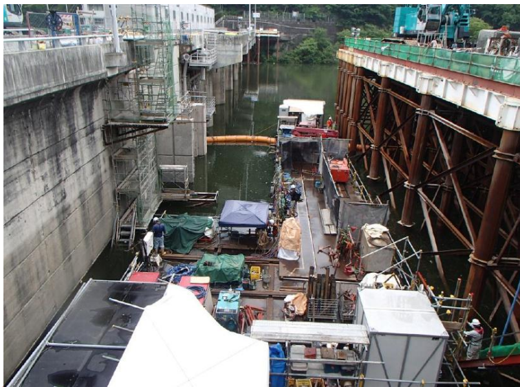
6月16日 取水塔撤去
