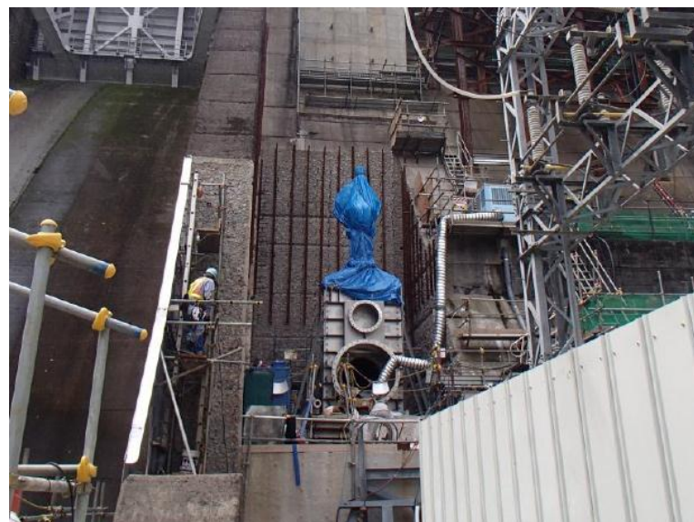
6月16日 放流ゲート設置
