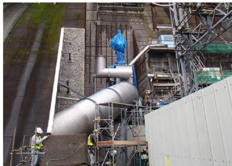
6月23日 放流ゲート設置
