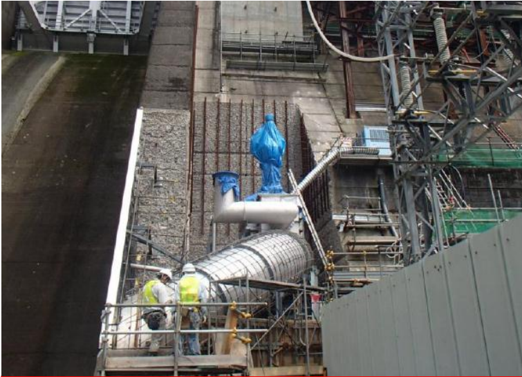
6月30日 ゲート室構築
