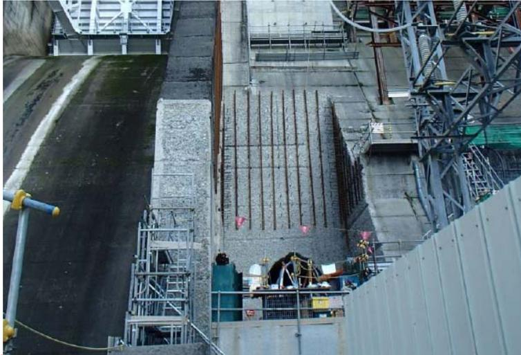
5月7日 仮設構台撤去完了、堤体削孔作業終了
