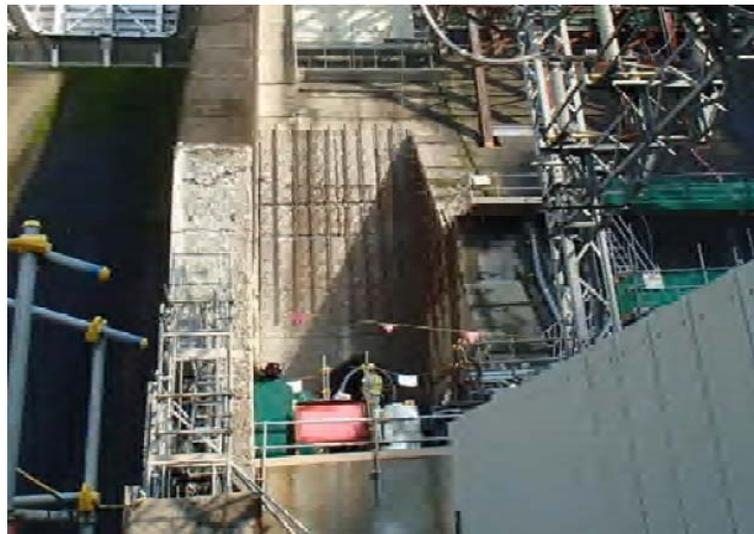
5月19日 放流管巻立てコンクリート打設準備
