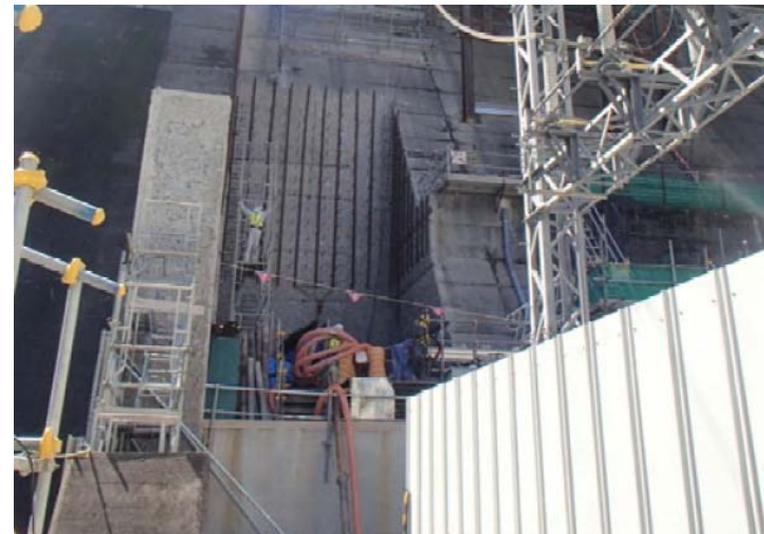
5月26日 放流管巻立てコンクリート打設準備
