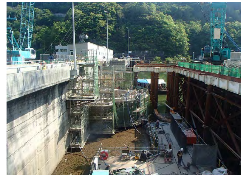
4月28日 取水塔撤去
