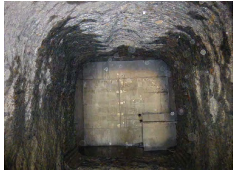
4月14日 堤体削孔作業完了
