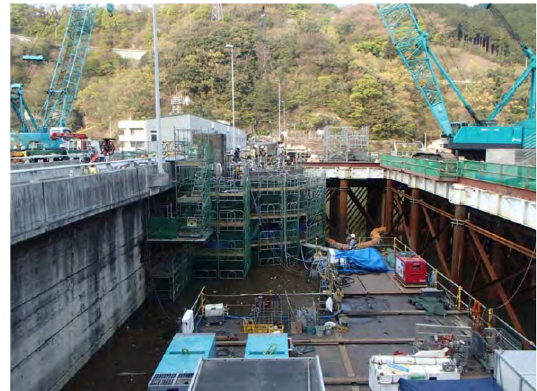
4月14日 取水塔撤去
