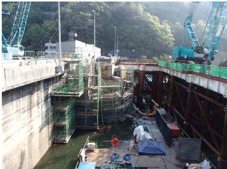
4月21日 取水塔撤去
