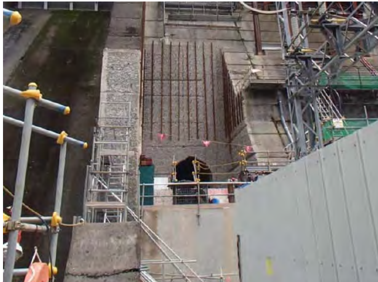
4月21日 掘削用仮設構台撤去
