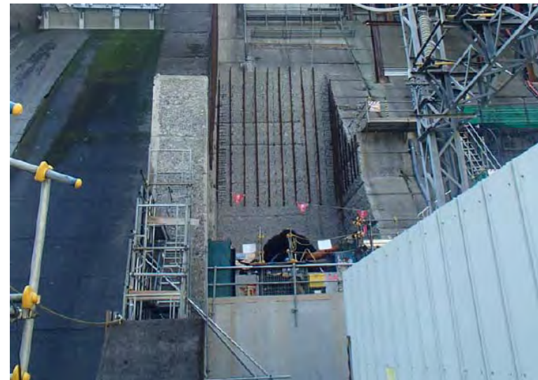
4月28日 掘削用仮設構台撤去完了
