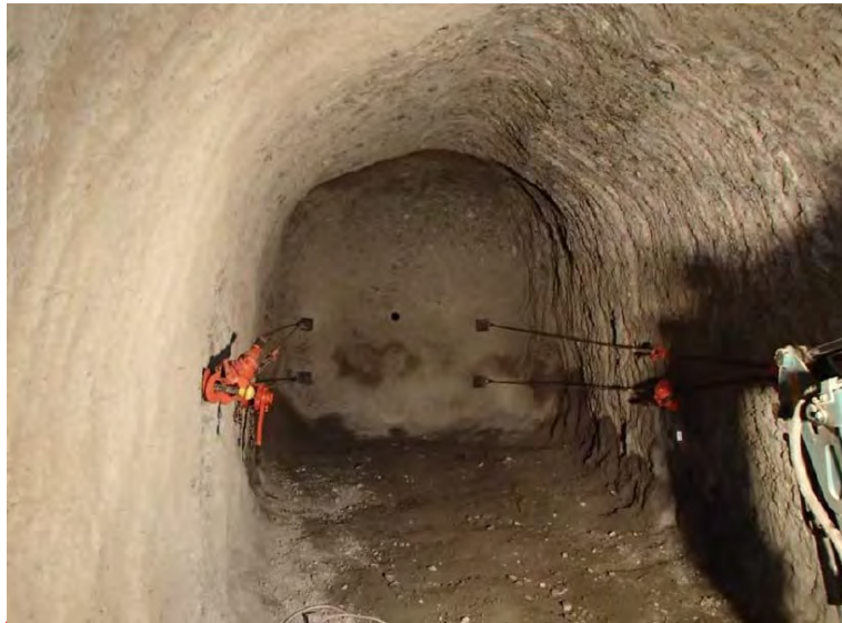
4月7日 堤体削孔作業
