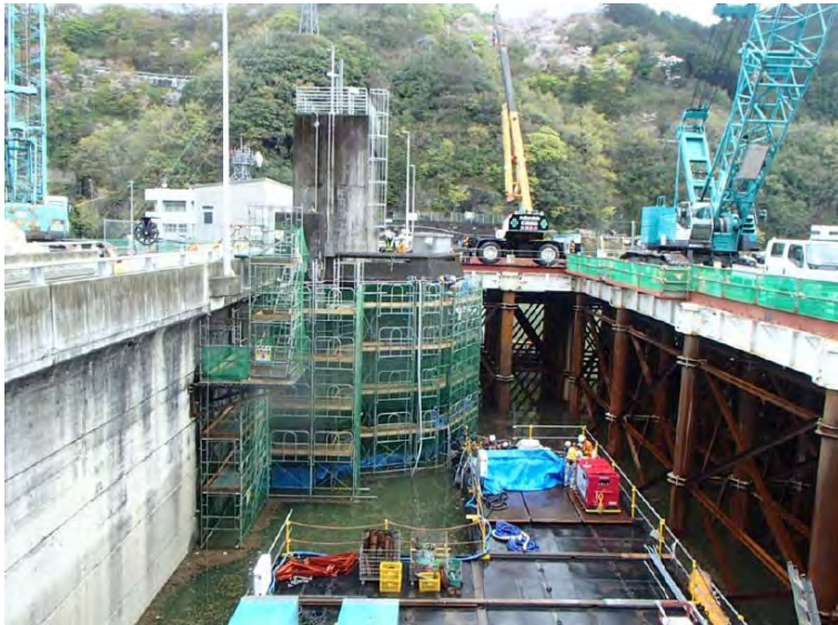
4月7日 取水塔撤去
