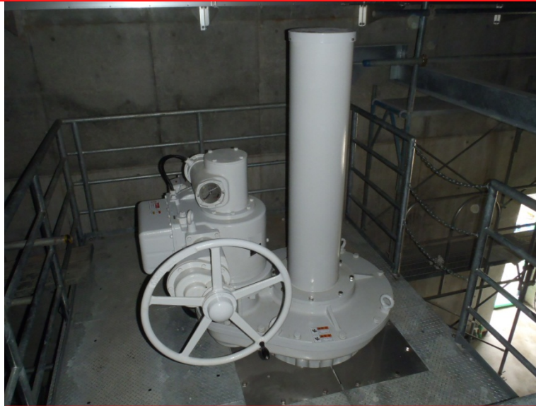
10月6日 低水放流設備完成(ジェットフローゲート)
