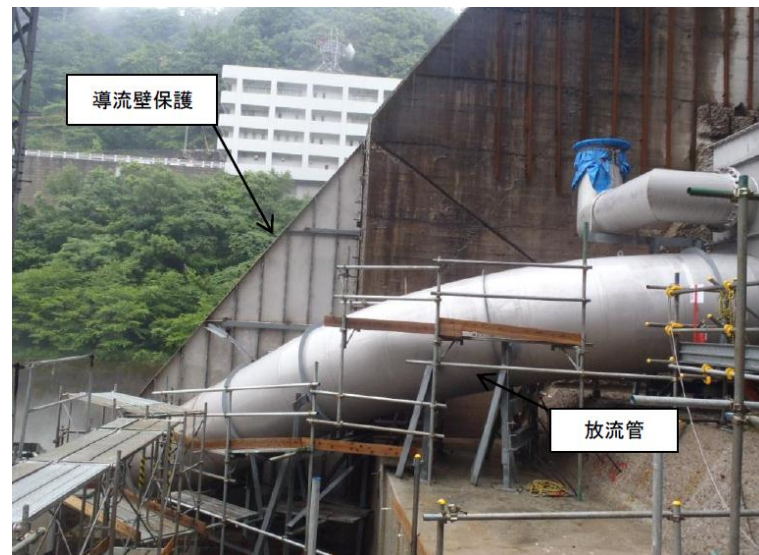
6月23日 放流管据付
