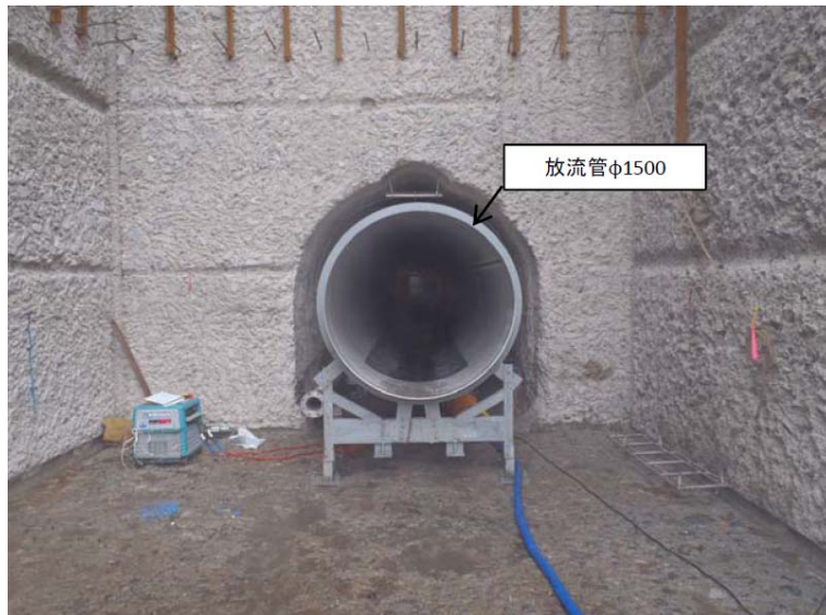
5月19日 放流管据付完了(トンネル入口まで)
