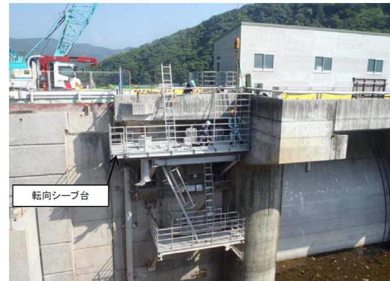
5月26日 転向シーブ台設置
