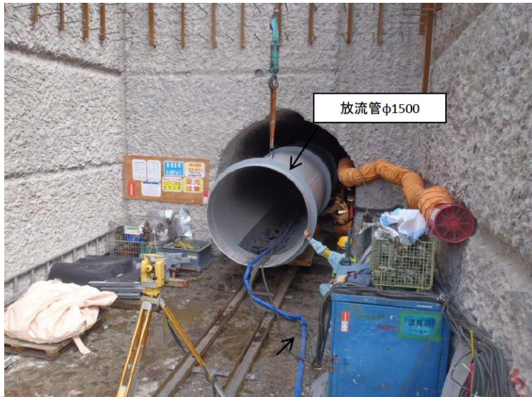
5月7日 放流管据付作業
