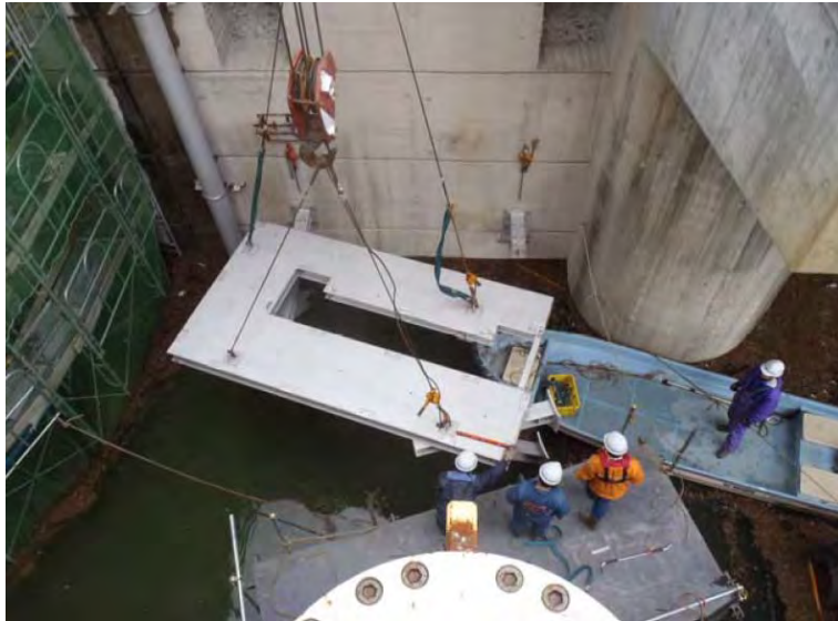
4月7日 予備ゲート点検架台設置
