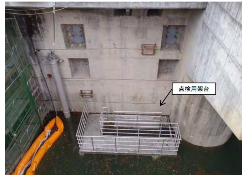
4月14日 予備ゲート点検架台設置
