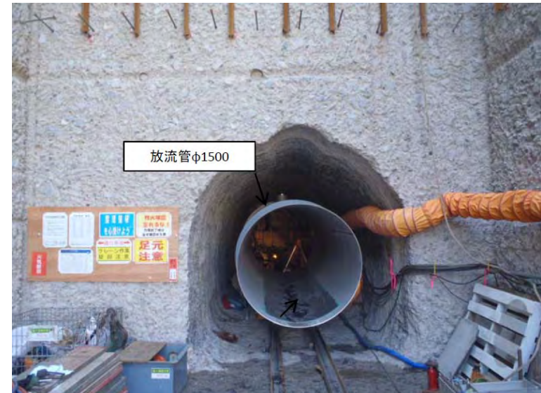
4月28日 放流管据付作業
