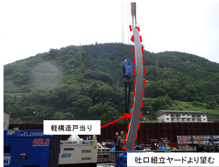
7月10日 主ゲート戸当り設置
