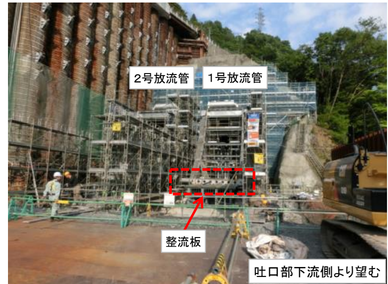
5月16日 整流板据付
