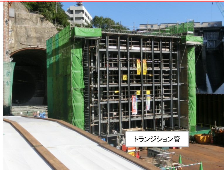
9月14日 トランジション管引き込み準備
