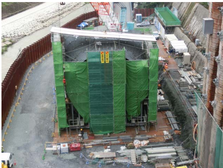
9月7日 トランジション管溶接
