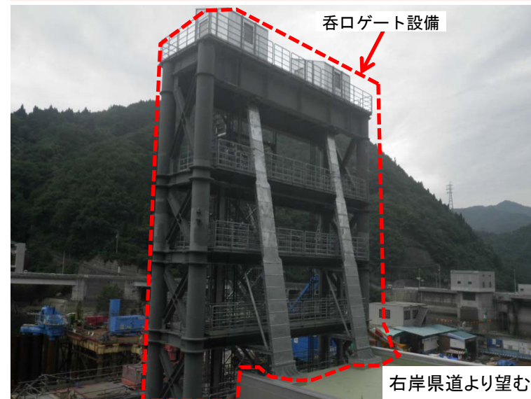
6月11日 機械設備全ての据付完了
