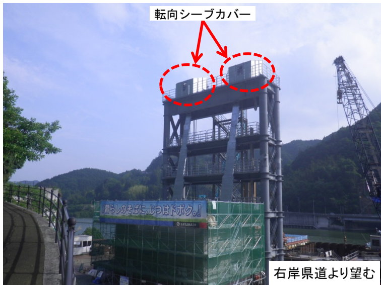
5月21日 転向シーブカバー据付
