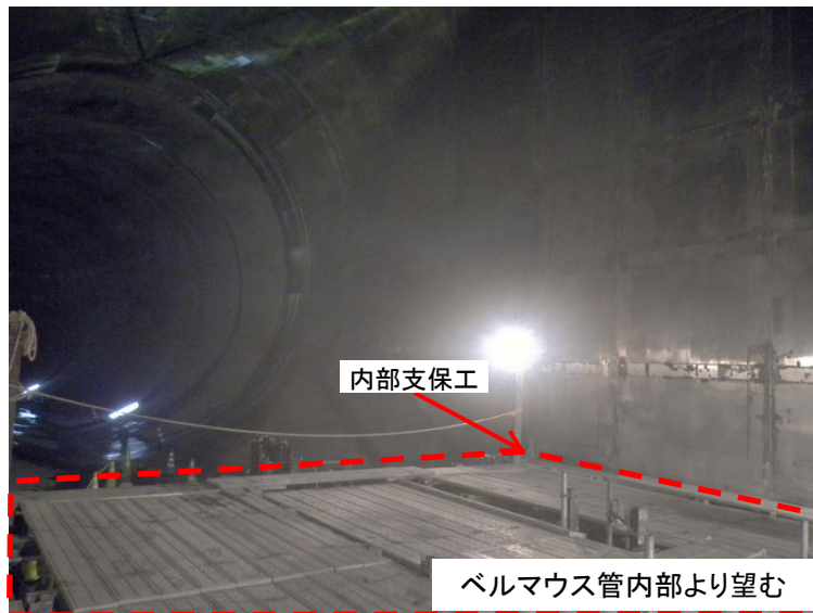
6月19日 ベルマウス管内部支保工(下流部)撤去
