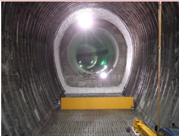
3月7日 底盤鉄筋組立
