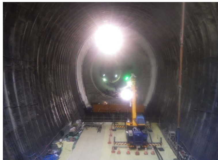
3月14日 底盤鉄筋組立
