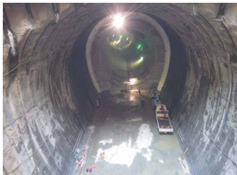
3月28日 立坑内片付け
