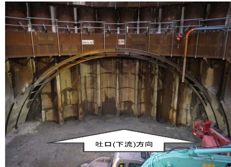
11月9日 立坑内迎え掘り掘削
