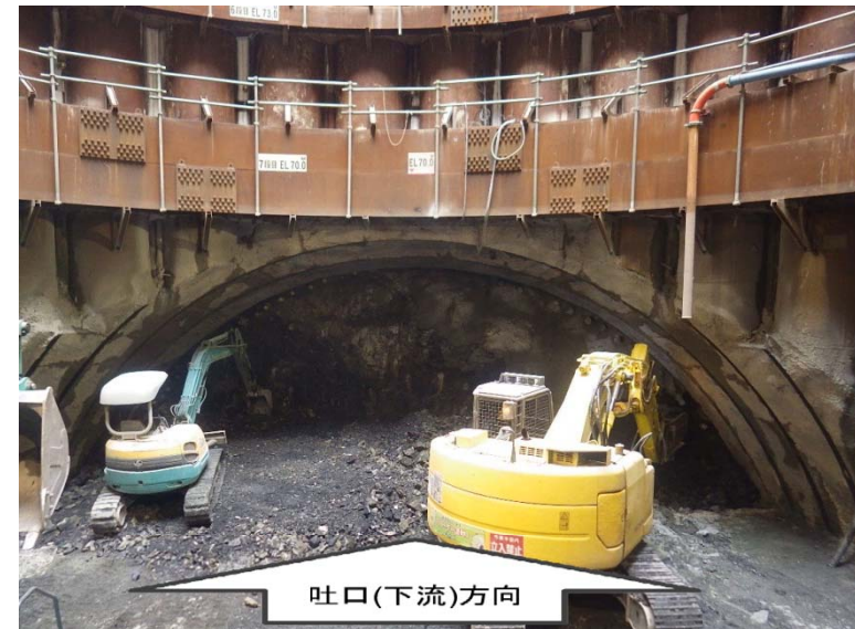
11月23日 立坑内迎え掘り掘削
