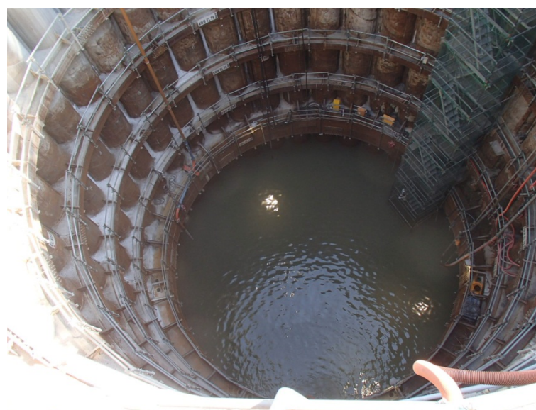
10月26日 立坑内排水
