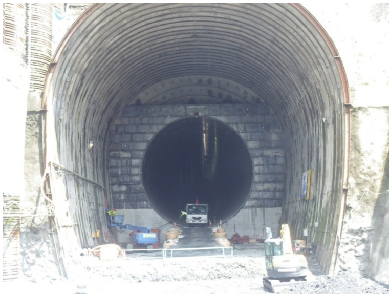
7月20日 放流管設置完了
