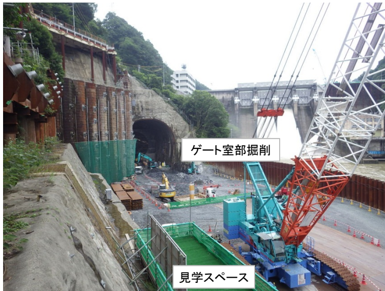
7月6日 放流管内部支保工解体、ゲート室部掘削
