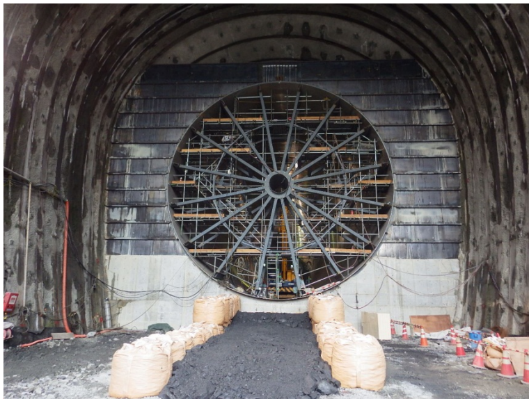
7月6日 内部支保工解体
