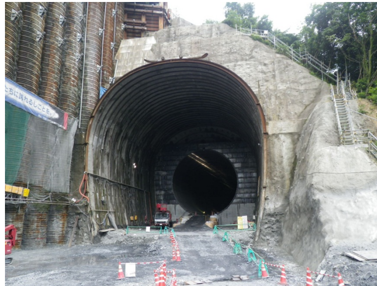
7月13日 内面仕上げ
