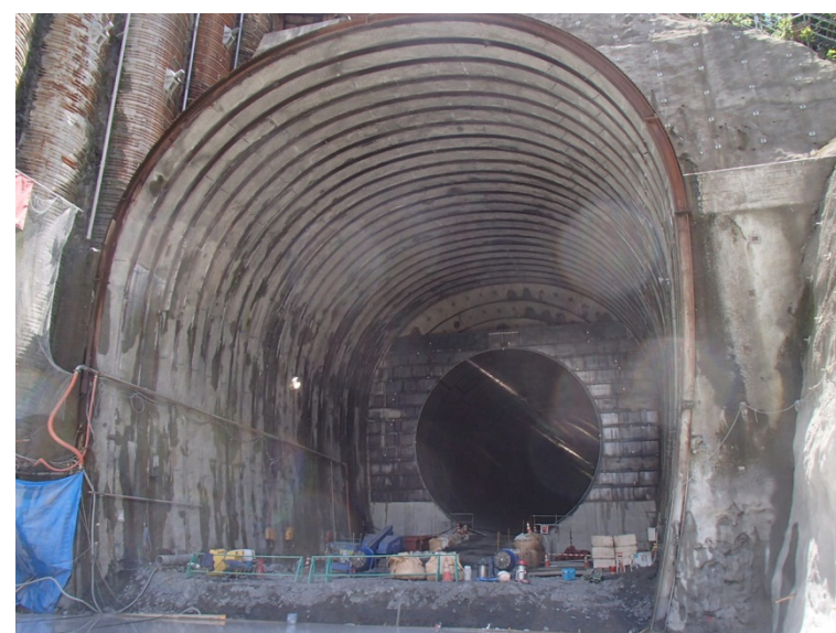
7月27日 放流管設置完了
