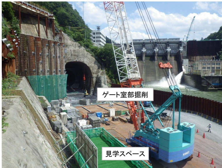
7月20日 ゲート室部掘削
