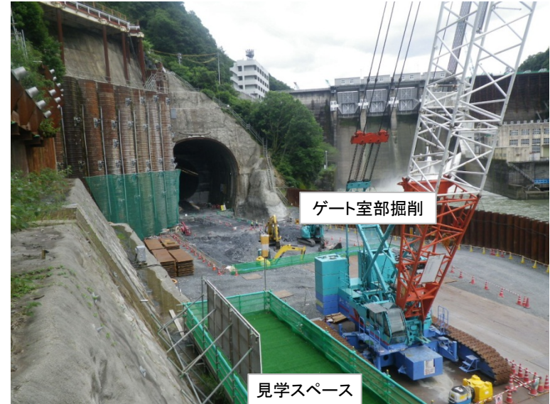
7月13日 ゲート室部掘削
