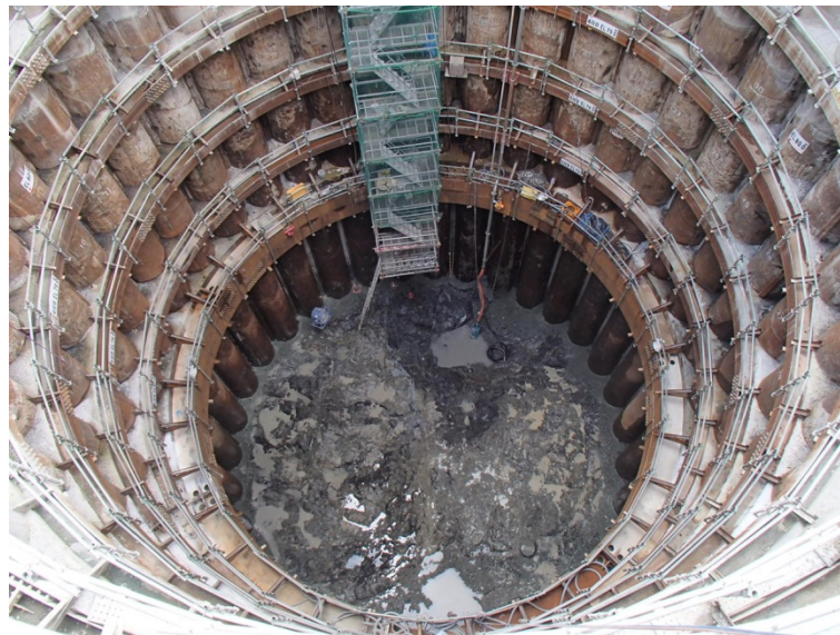
7月20日 立坑掘削、鋼管内カーテングラウト
