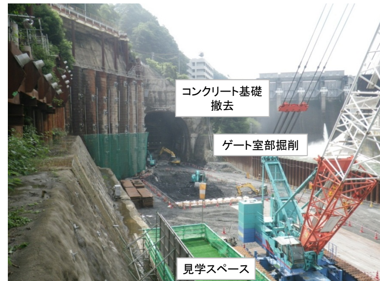
6月22日 コンクリート基礎撤去、ゲート室部掘削
