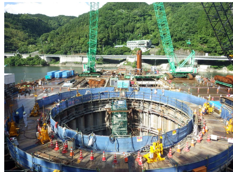
6月8日 鋼管矢板建込、立坑掘削、鋼管内カーテングラウト
