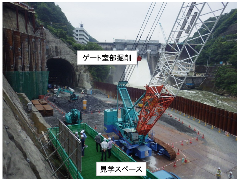
6月15日 ゲート室部掘削
