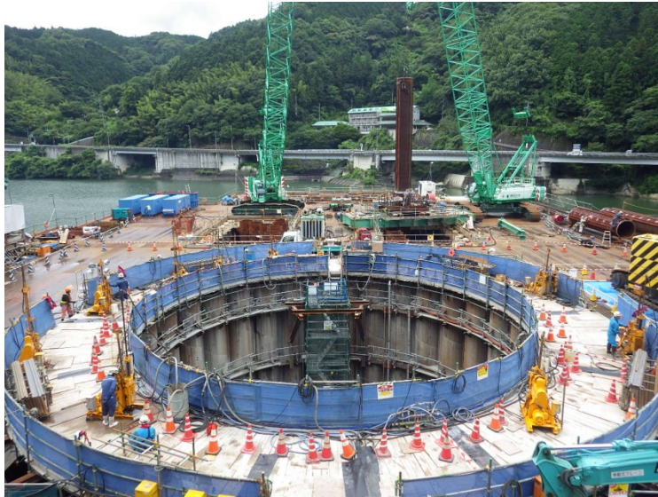
6月29日 鋼管矢板建込、立坑掘削、鋼管内カーテングラウト
