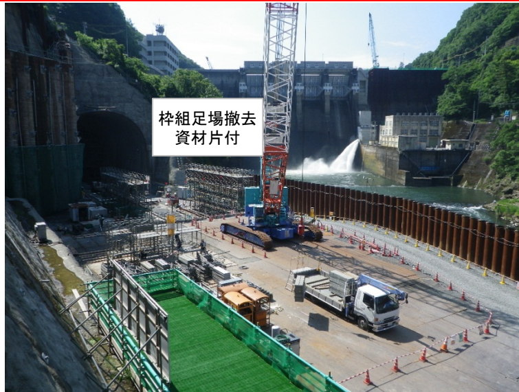
6月1日 枠組足場撤去、資材片付
