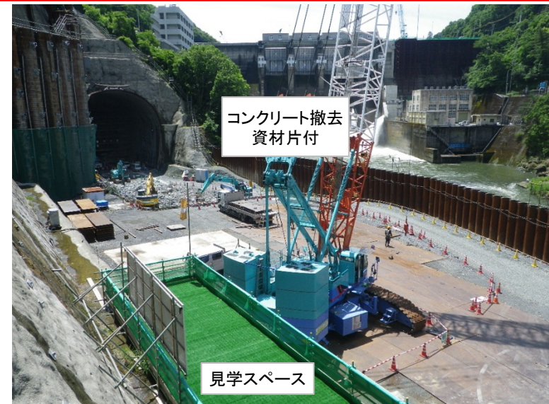
6月8日 コンクリート基礎撤去、資材片付け
