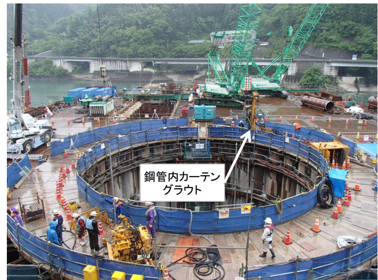
5月11日 鋼管矢板建込、管内カーテングラウト、立坑掘削
