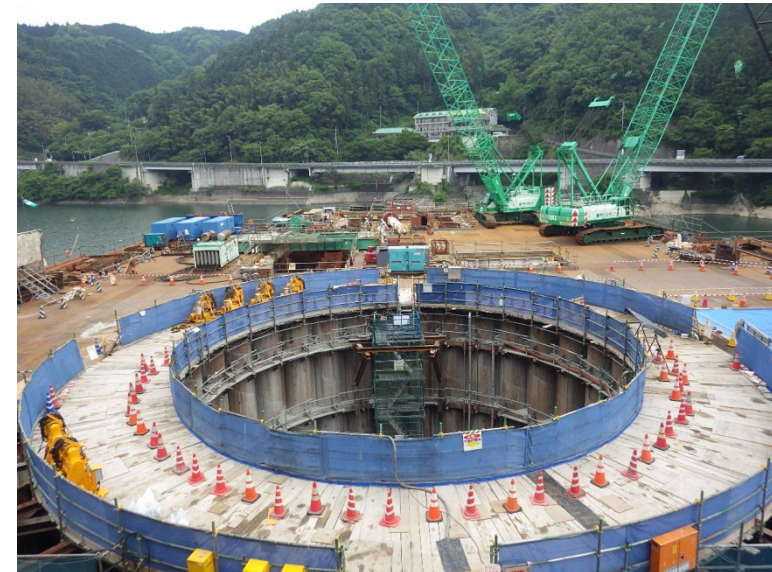
5月25日 鋼管矢板建込、立坑掘削
