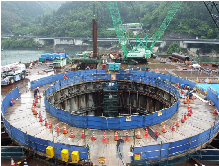
5月18日 鋼管矢板建込、立坑掘削
