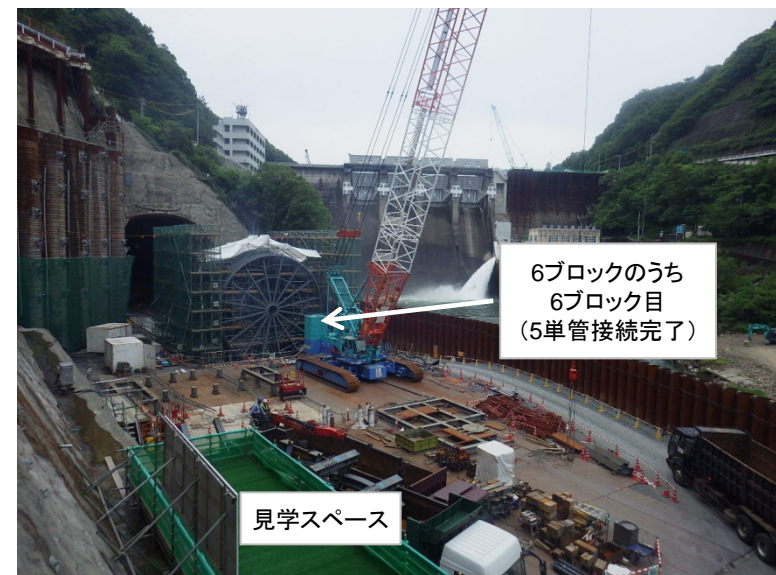
5月25日 放流管組立、資材片付け
