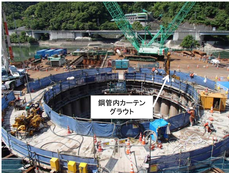
5月4日 鋼管矢板建込、管内カーテングラウト、立坑掘削
