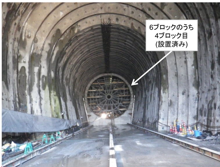
5月4日 放流管巻立コンクリート打設、内部支保工解体
