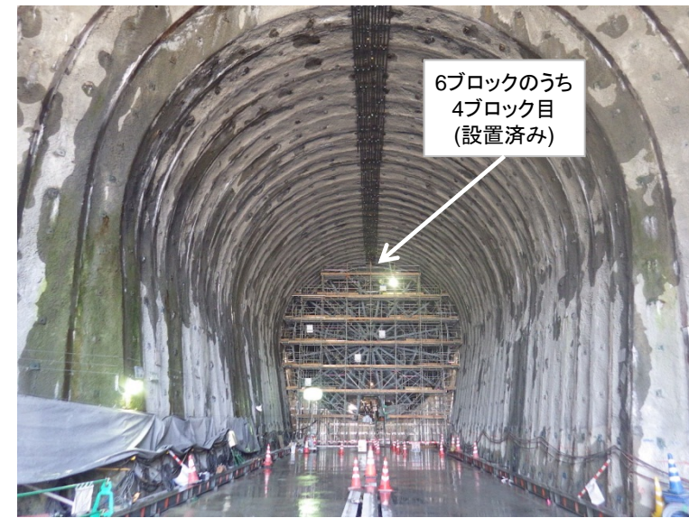
4月27日 放流管巻立コンクリート打設、放流管連結
