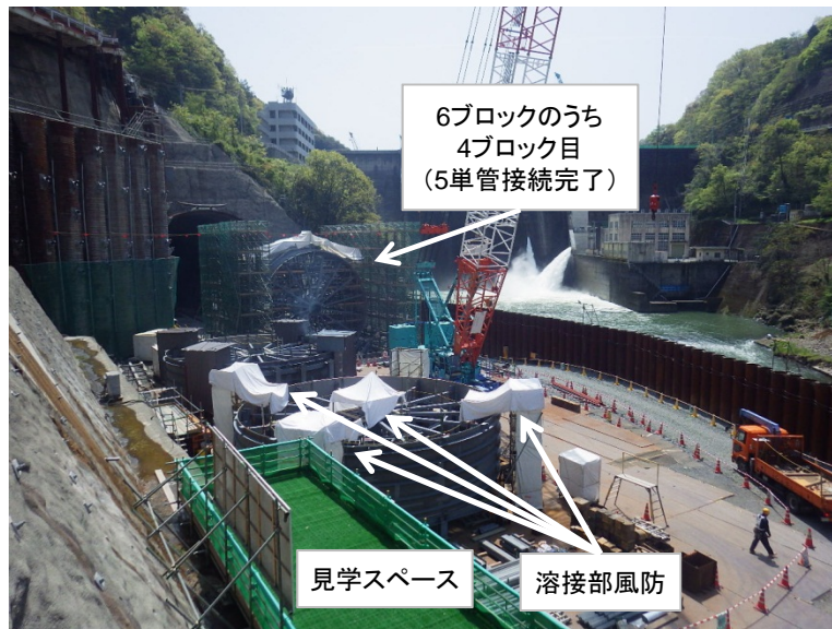
4月20日 放流管組立、放流管トンネル坑内搬入
