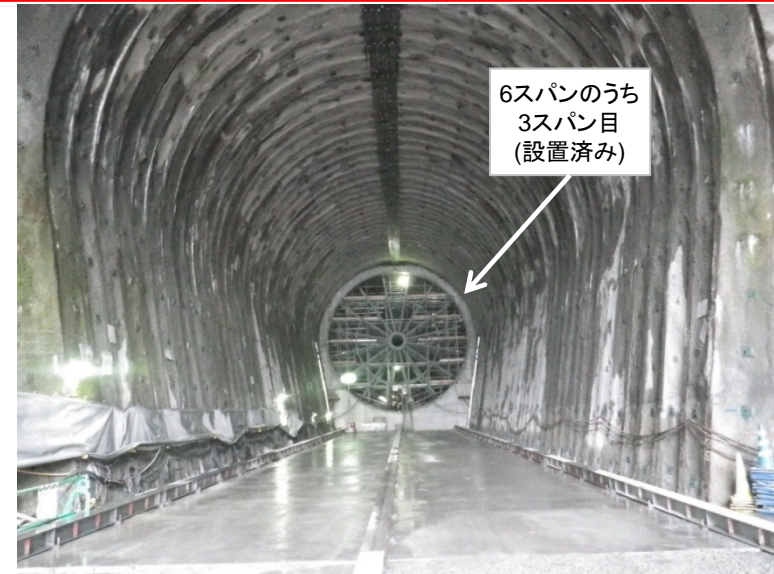
4月13日 放流管巻立コンクリート打設、内部支保工解体
