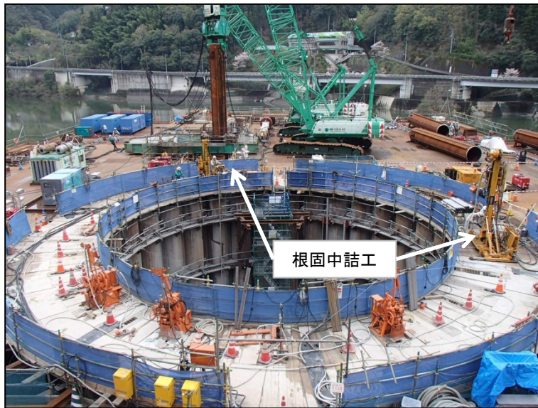
4月6日 鋼管矢板建込、根固中詰工、立坑掘削
