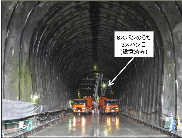
4月6日 放流管巻立コンクリート打設
