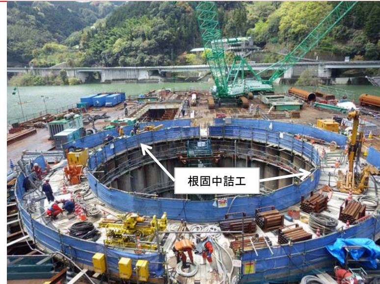
4月13日 鋼管矢板建込、根固中詰工、立坑掘削
