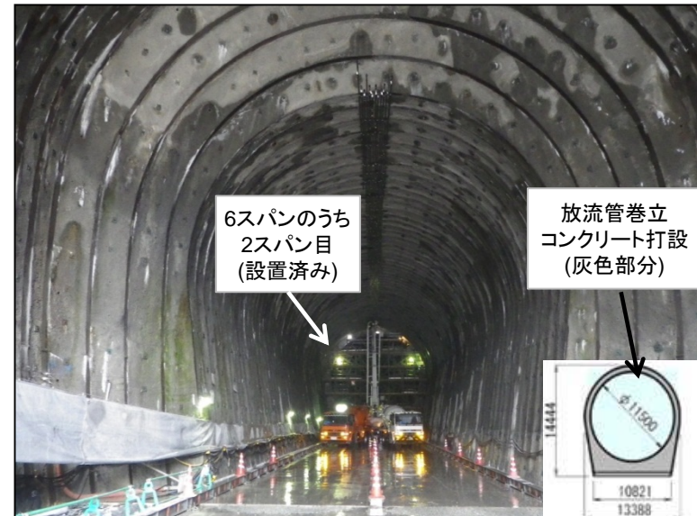
3月23日 放流管巻立コンクリート打設、放流管連結
