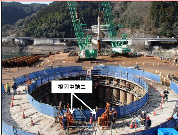
3月2日 鋼管矢板建込、根固中詰工、立坑掘削
