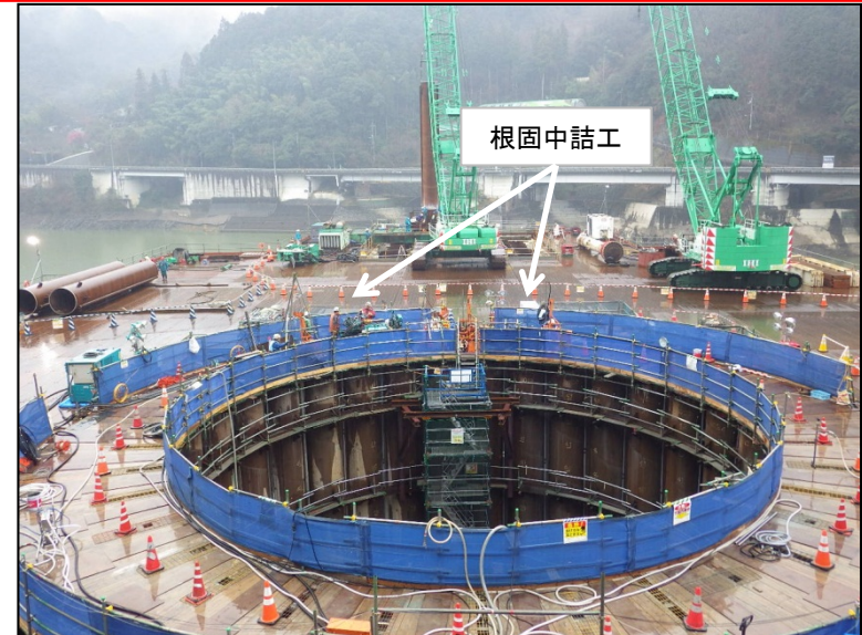
3月9日 鋼管矢板建込、根固中詰工、立坑掘削
