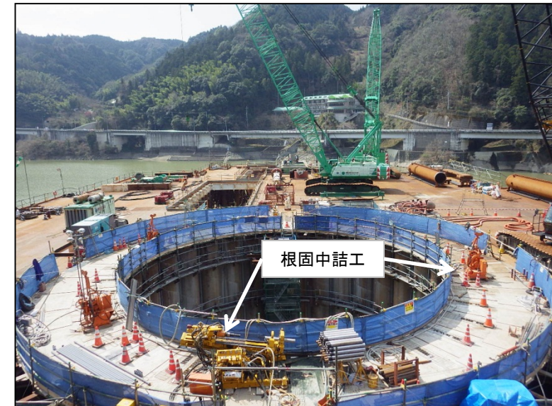
3月23日 鋼管矢板建込、根固中詰工、立坑掘削
