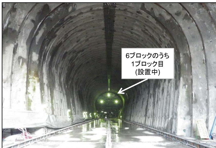
2月16日 放流管縦送り
