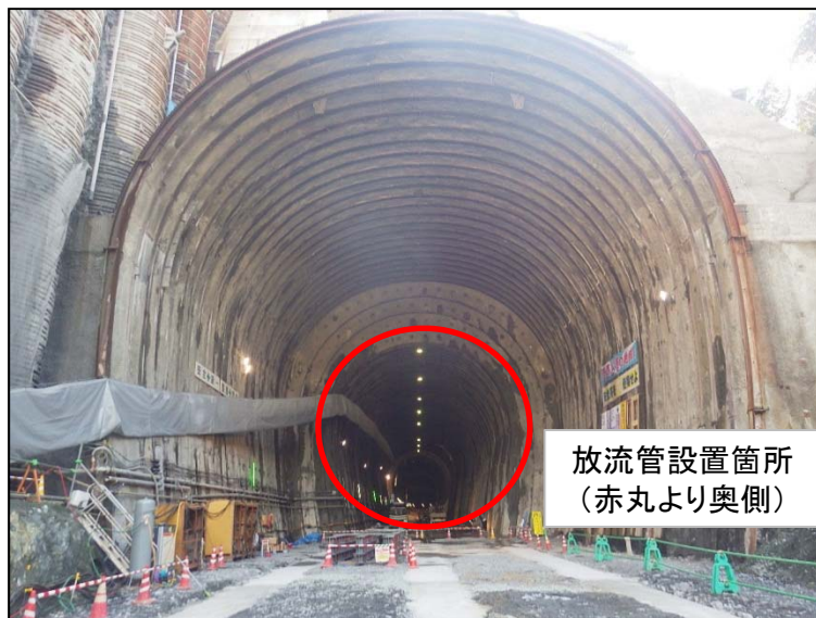
2月2日 放流管レール基礎構築
