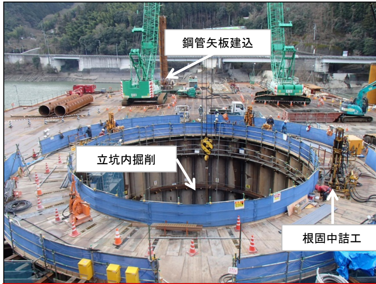
2月2日 鋼管矢板建込、根固中詰工、立坑掘削
