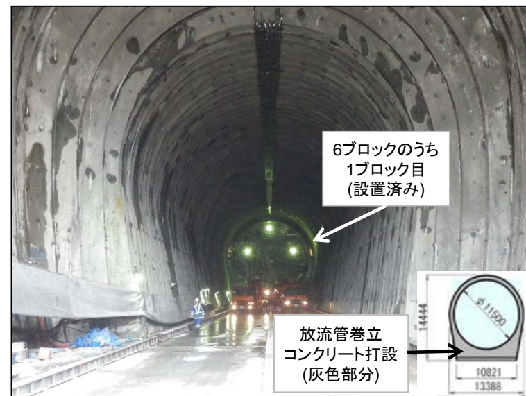
2月23日 放流管巻立コンクリート打設
