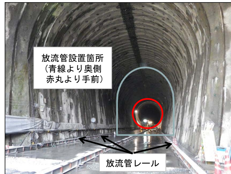
2月9日 放流管レール基礎構築
