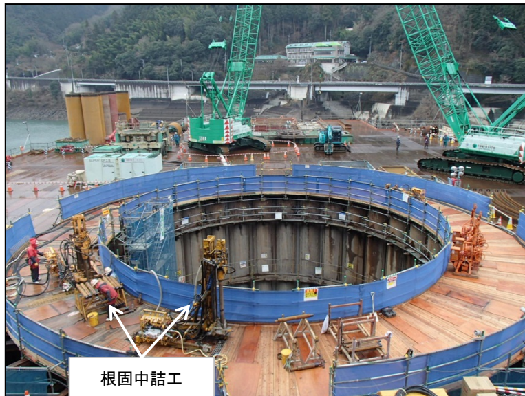
1月19日 鋼管矢板建込導枠設置、根固中詰工
