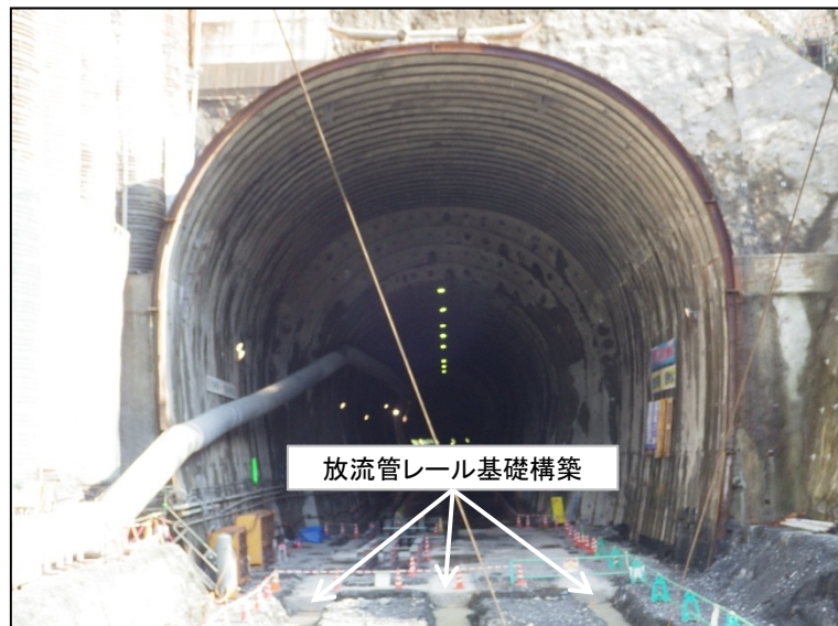
1月19日 放流管レール基礎構築
