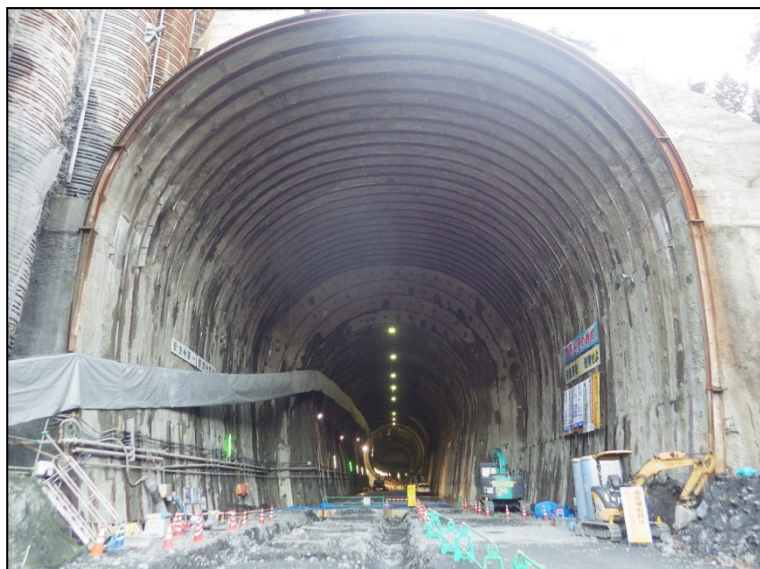
1月5日 均しコンクリート打設(完了)
