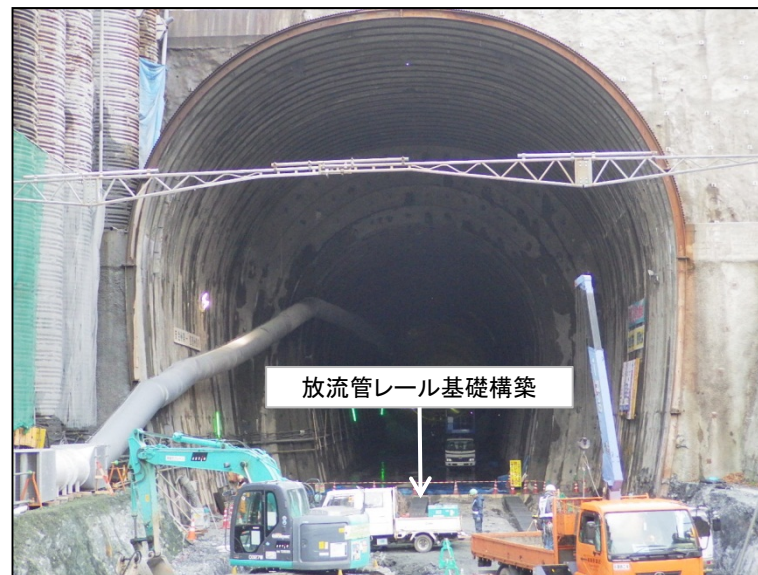
1月13日 放流管レール基礎構築
