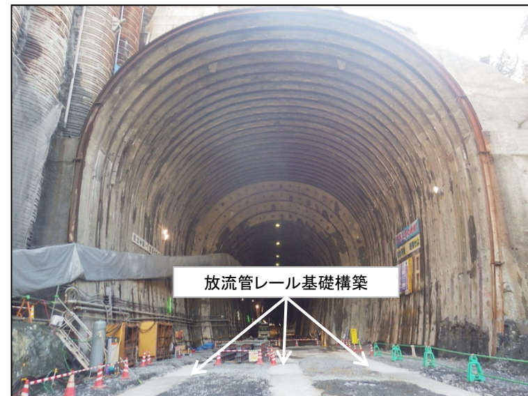
1月26日 放流管レール基礎構築
