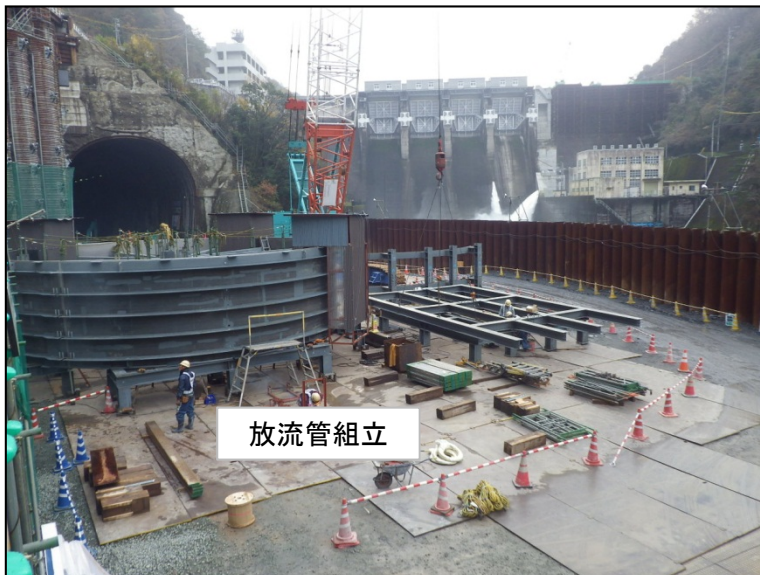
12月15日 放流管据付架台基礎工、放流管組立
