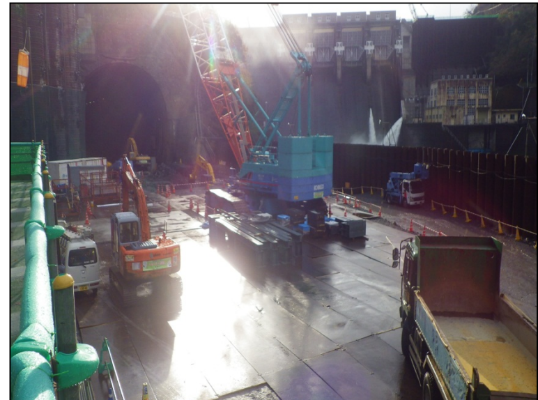
12月8日 放流管据付架台基礎工
