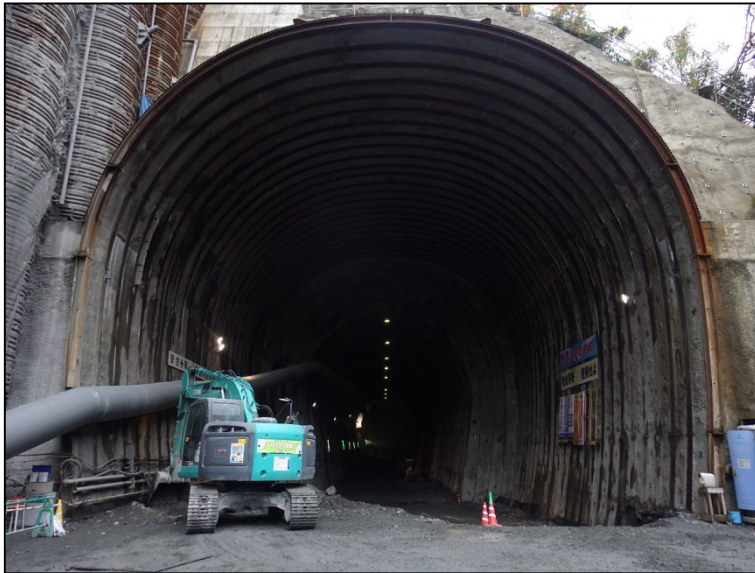
12月1日 残土搬出、止水工
