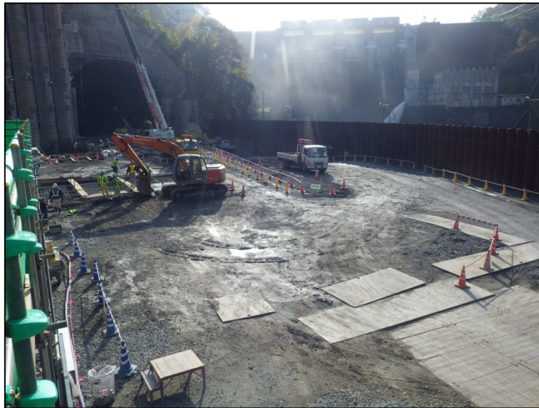
12月1日 深礎アンカー工、放流管据付架台基礎工
