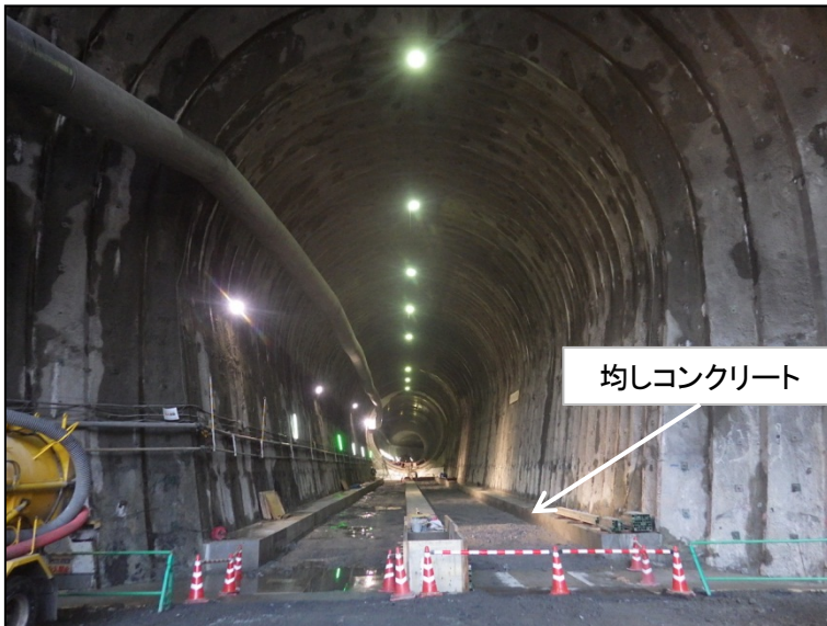
12月15日 均しコンクリート打設、止水工
