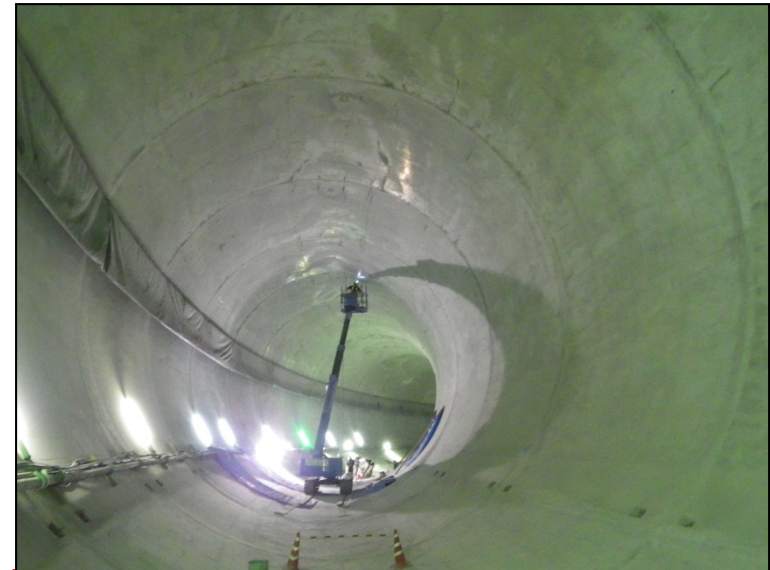
12月8日 残土搬出、止水工
