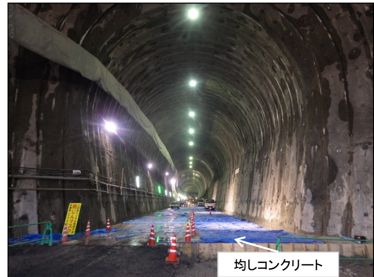
12月22日 均しコンクリート打設(完了)、止水工
