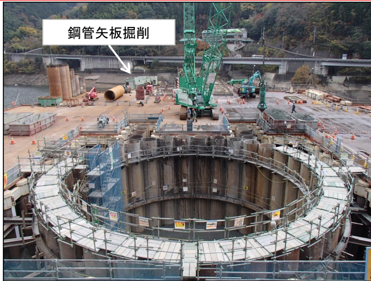
12月1日 鋼管矢板部掘削、鋼管継手処理準備
