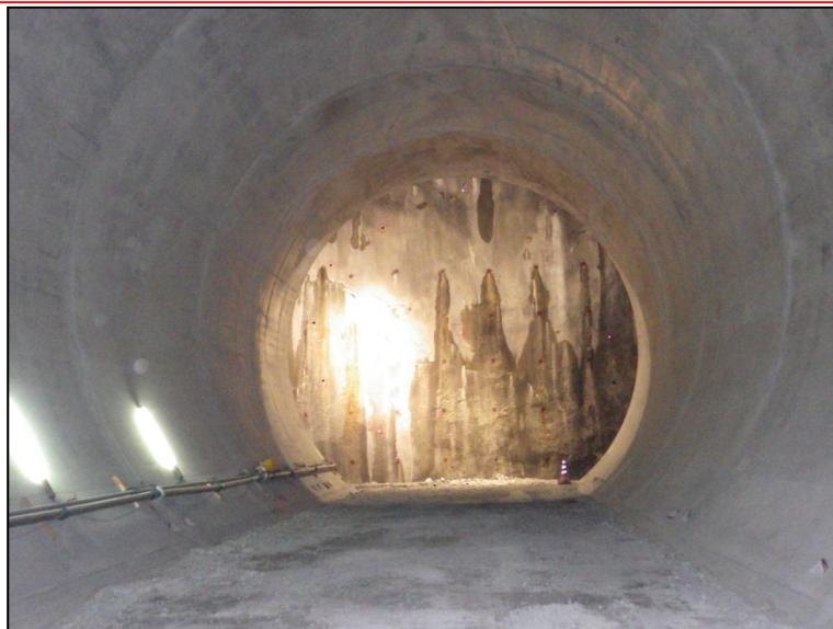
11月4日 覆工完了
