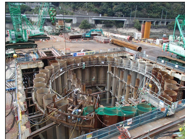
10月27日 流入水路掘削、鋼管矢板打込み
