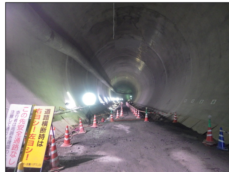
10月27日 覆工完了
