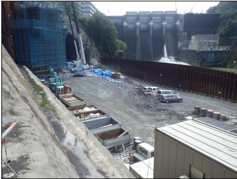
10月6日 深礎アンカー工、調査ボーリング
