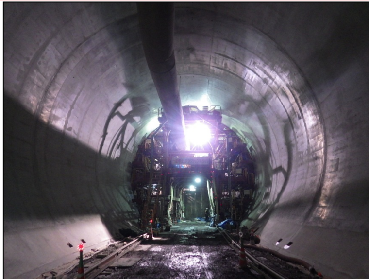
10月6日 坑内仮設備解体
