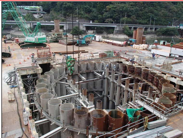
10月6日 立坑内仮設工台撤去、流入水路掘削
