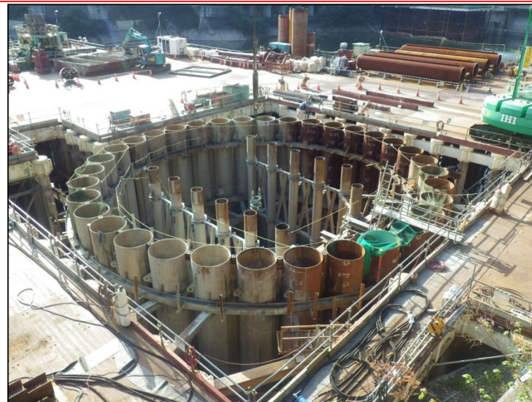
10月14日 立坑内仮設工台撤去、流入水路掘削
