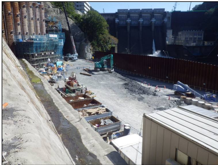
10月20日 深礎アンカー工、調査ボーリング
