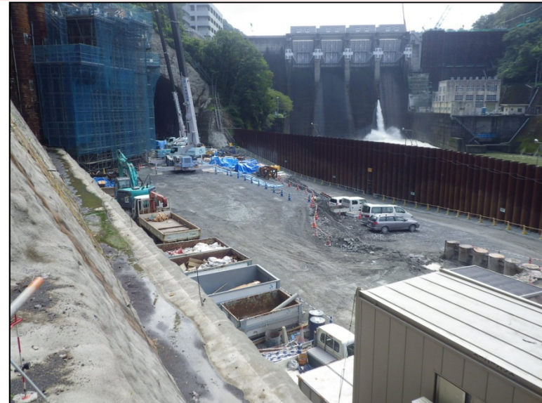
10月14日 深礎アンカー工、調査ボーリング
