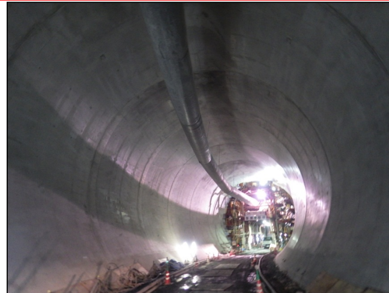
10月14日 セントル解体準備
