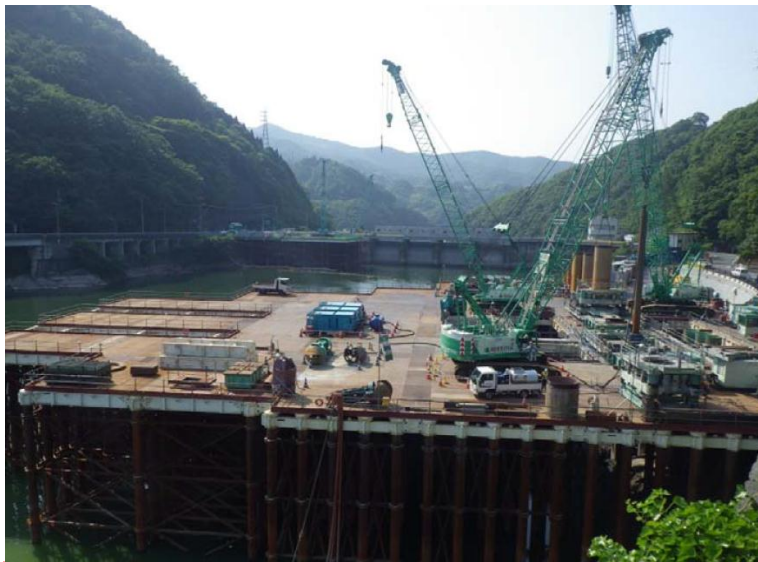
6月2日 呑口立坑掘削
