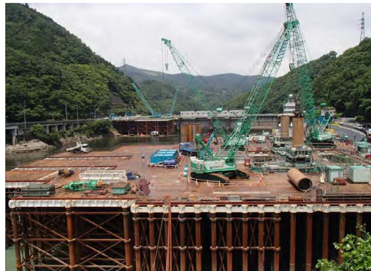
6月9日 呑口立坑掘削
