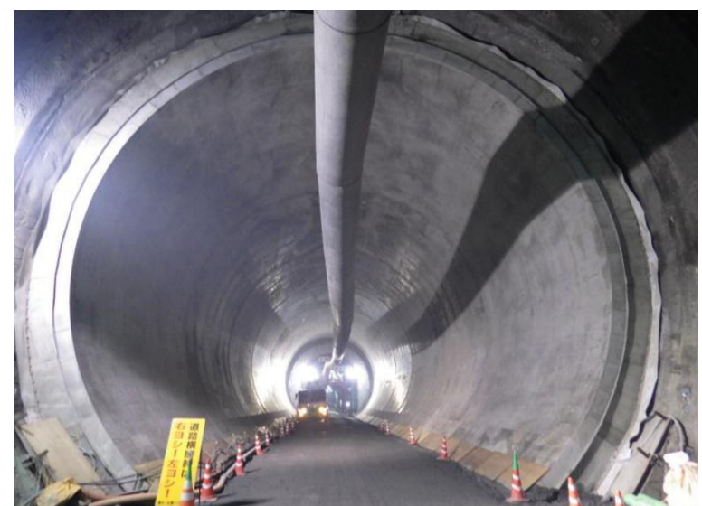
6月23日 インバート工、覆工
