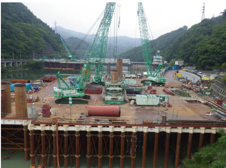
6月16日 呑口立坑掘削、鋼管矢板打込み準備
