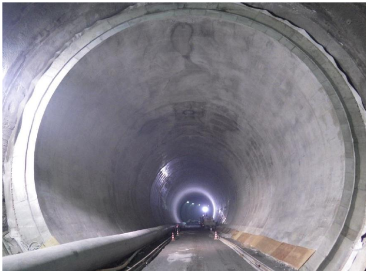
6月16日 インバート工、覆工
