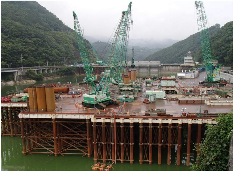
6月30日 呑口立坑掘削、鋼管矢板打込み準備
