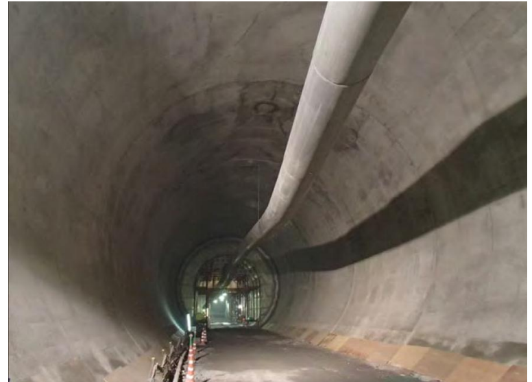
6月9日 インバート工、覆工
