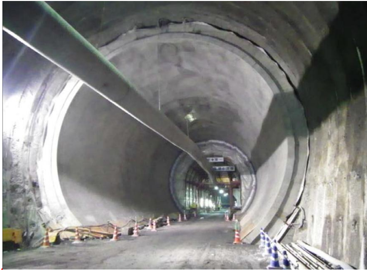
6月2日 インバート工、覆工
