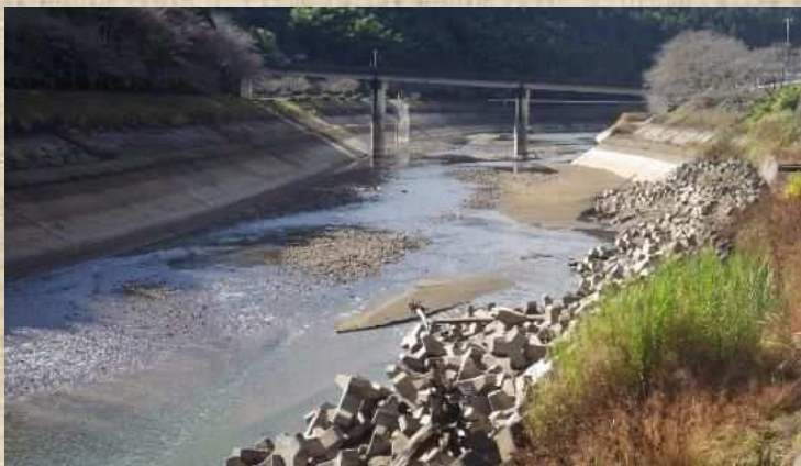
四道橋付近の貯水池状況（11月11日撮影）
