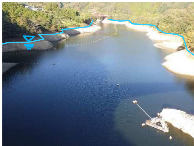
板ヶ谷橋付近
