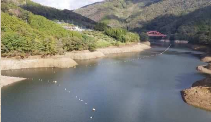
出合大橋付近の貯水池状況（11月11日撮影）
