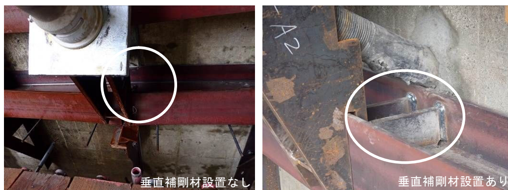
図10-1 仮設材（梁ブラケット）荷重支持点への垂直補剛材設置対応例
